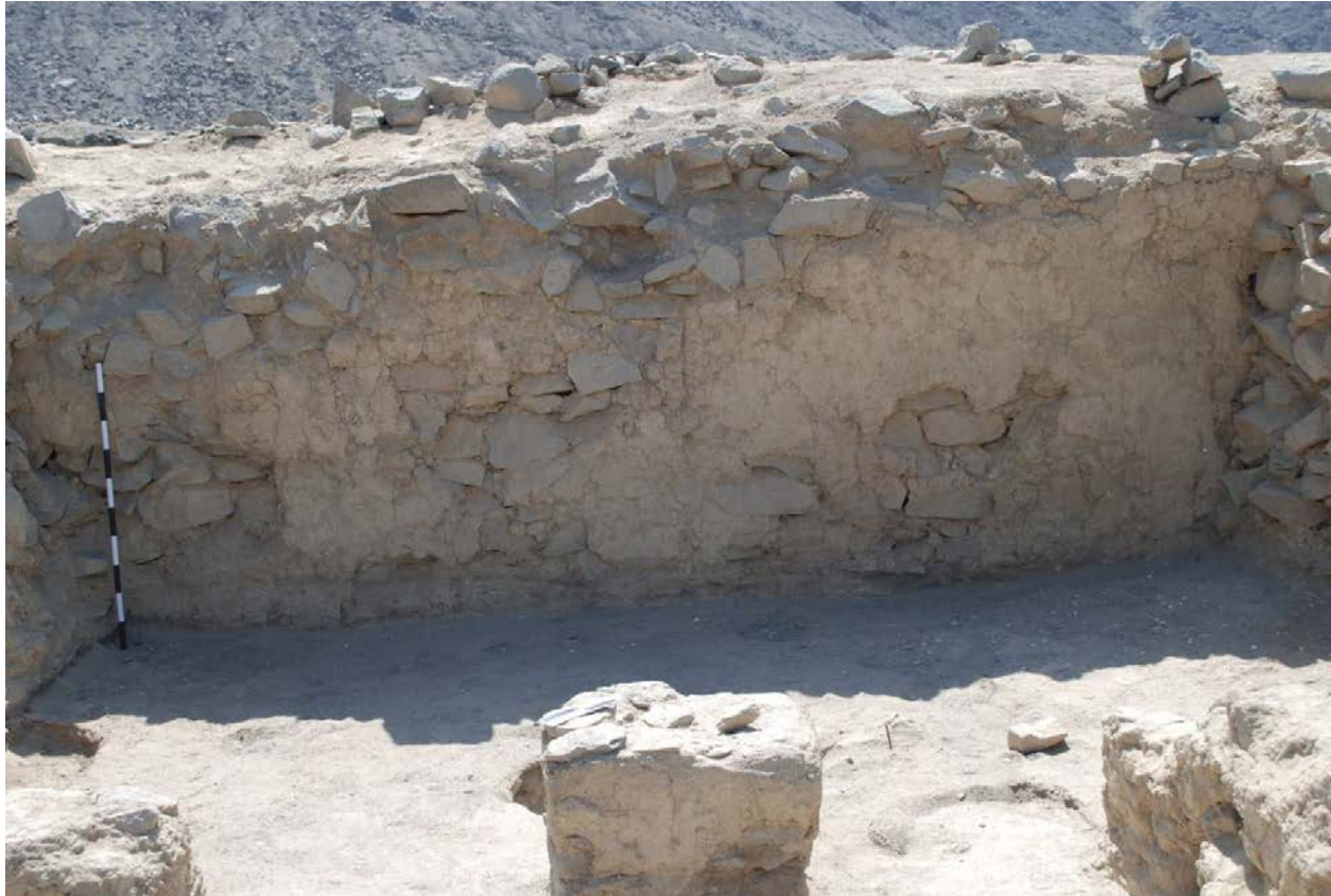
Figura 5.1: Materiales y técnicas constructivas. Imagen del Recinto 6.
