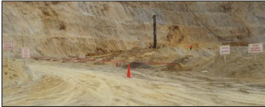
Figura 10: Zona señalizada en área de carguío de voladura
