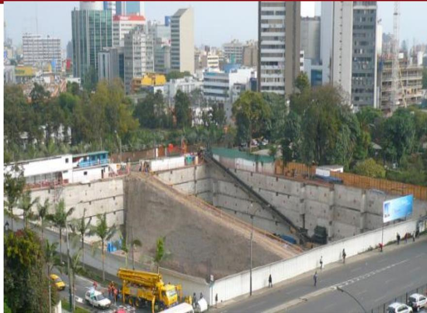
**Figura 1.0:** Foto panorámica del movimiento de tierras. Construcción de rampa y disposición de la faja transportadora. Fuente: Proyecto GyM S.A
