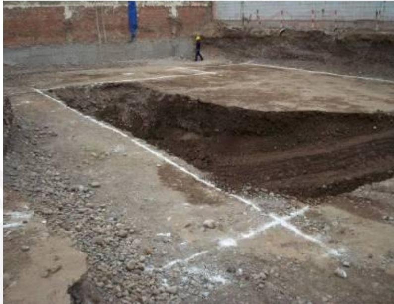
**Figura 1.0:** Vista del replanteo topográfico posterior a la entrega del terreno. Fuente: Proyecto GyM S.A
