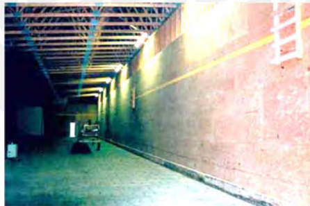
Figura 1.3 Almacén con ventilación forzada para papa granel hasta una altura de 3m.
