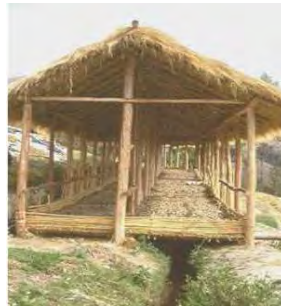
Figura 1.2 Almacén artesanal con estructura de madera.
