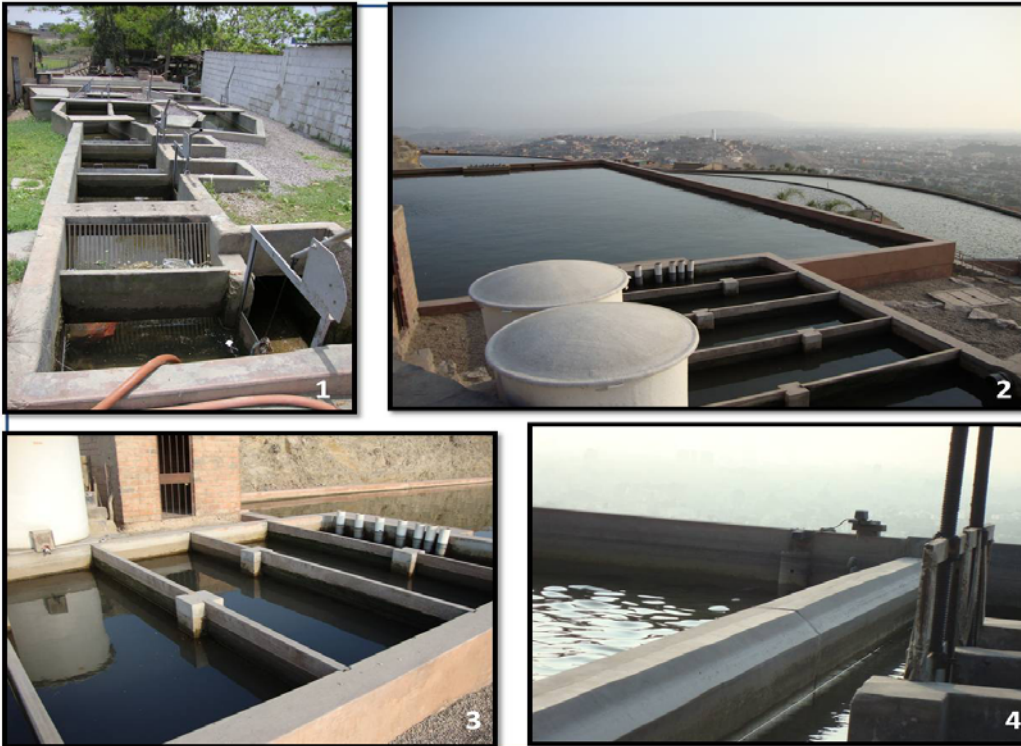
1. Zona de captación. 2. Reservorio y las lagunas de oxidación. 3. Trampa para grasas. 4. Tercera laguna y el dispositivo automático.
