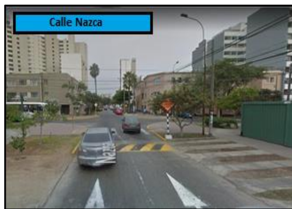
Figura 3.4 Vista de la vía en dirección de calle Nazca.
