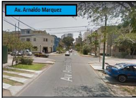
Figura 3.3 Vista de la vía en dirección de la Av. Arnaldo Márquez.
