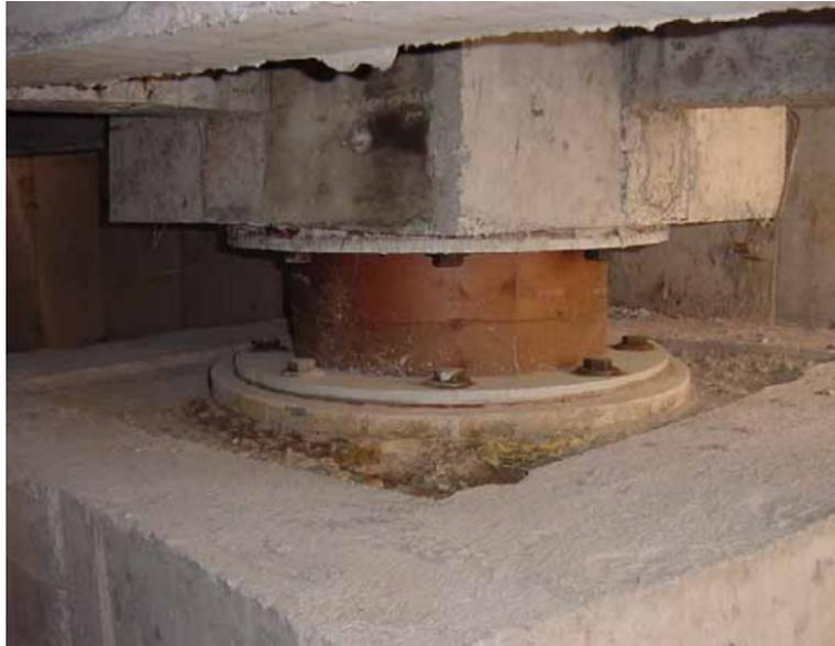
Fotografía 1. Aislador instalado en el edificio “San Agustín” en Santiago, Chile.
