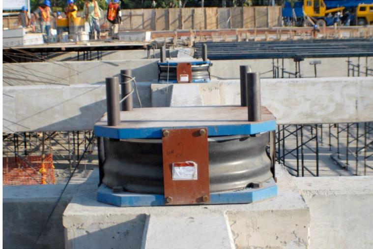
Fotografía 5. Aisladores sobre subestructura de sótano.
