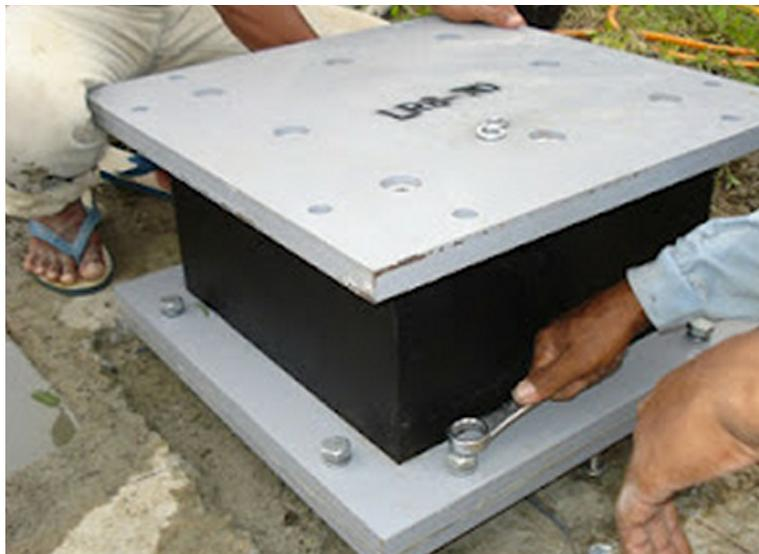
Fotografía 4. Instalación de un aislador de sección cuadrada.
