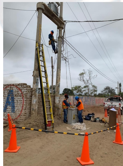
Figura 52. Trabajos de riesgos - Viru
