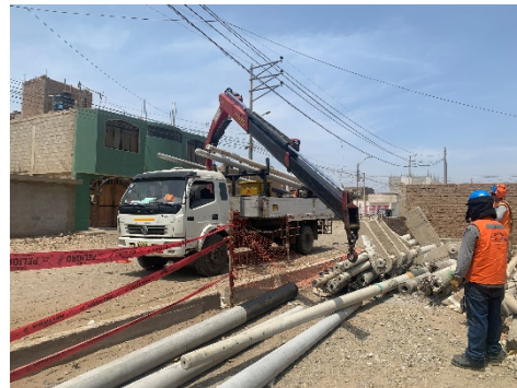
Figura 54. Trabajos de izaje – Pacasmayo
