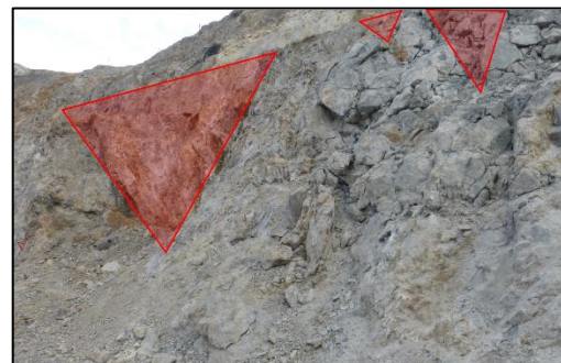
Figura 60. Falla tipo cuña y pérdida de material que se presenta para un banco del DG- I
