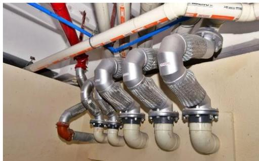
**Figura 2.10:** Tubería flexible (El universo web page, 2019)
