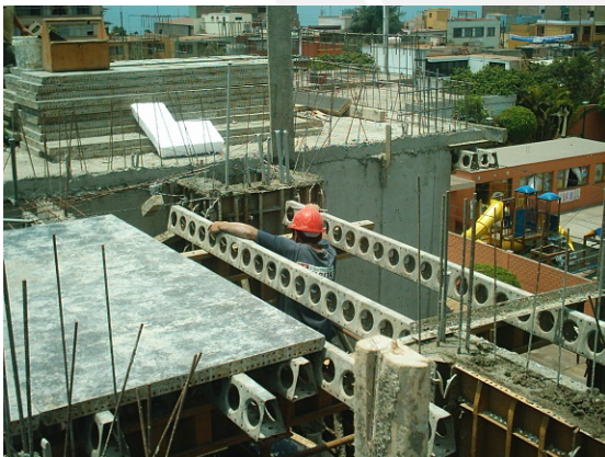
Foto 16: Detalle del sistema de apuntalamiento del sistema de encofrado de losa.
