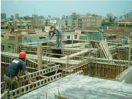
Foto 10: Madera utilizada para andamios interiores.
