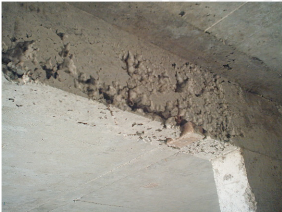
Foto 12: Cangrejera extrema en muro interior.
