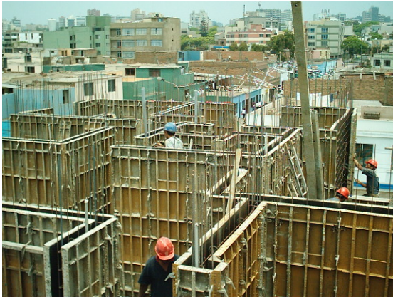
Foto 18: Vista exterior de paneles de encofrado de muros.
