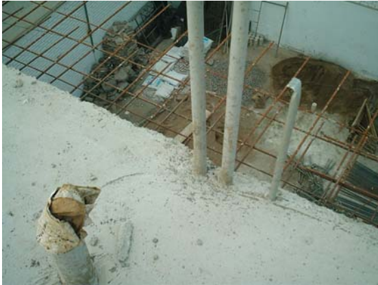
Foto 2: Acabado de losa de piso intermedio.
