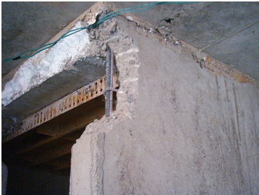
Foto 22: Sustrucción de encofrado metálico por madera.
