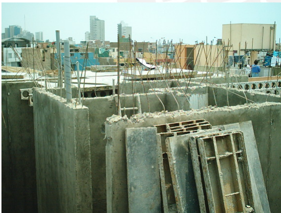
Foto 4: Aspecto final de muros de varios niveles.
