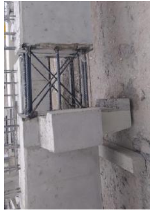
Figura A1.6. Zona de cajón para nudo en columna cuadrada
