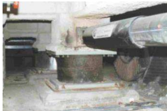
Figura 2.14. Sistema de aislador LDRB y amortiguador de fluido viscoso.
