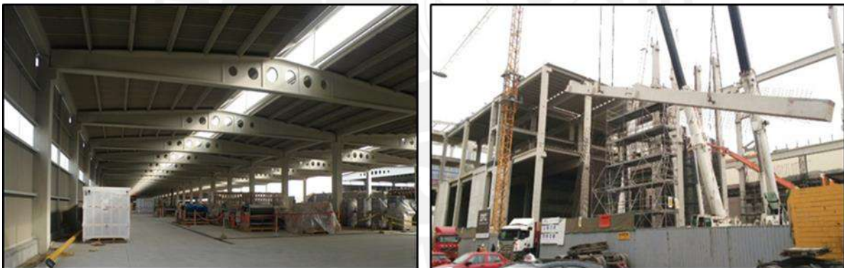
Figura 1.7. Edificaciones prefabricadas - Proyectos de Preansa Perú.
