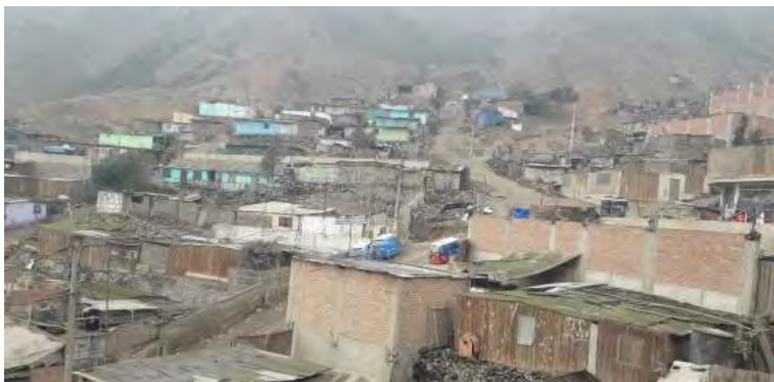
Ilustración 3. No existen escaleras para facilitar la movilidad de los residentes. Imagen propia.
