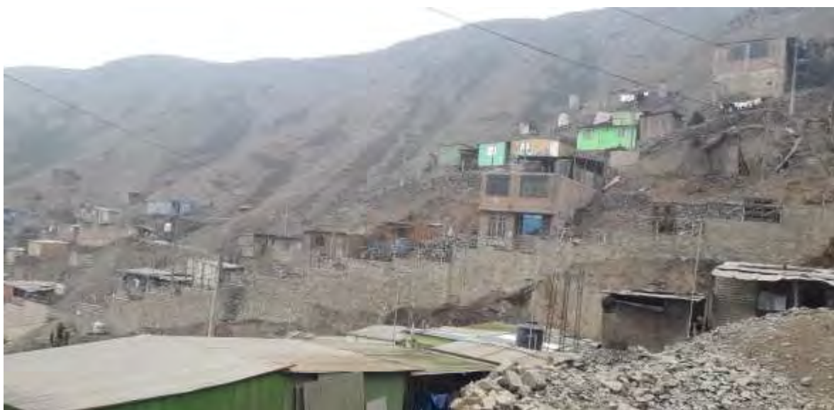
Ilustración 13. A pesar de la precariedad de las casas, la Asociación Paraíso cuenta con muros de contención. Imagen propia.
