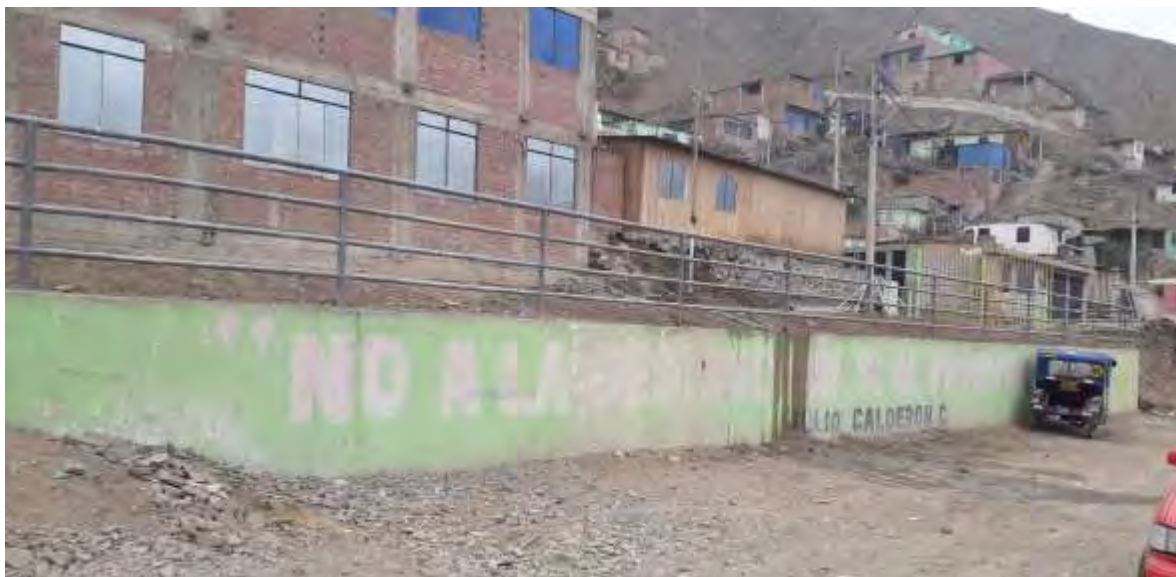
Ilustración 9. Muro en la entrada de la Asociación Paraíso. Imagen propia.
