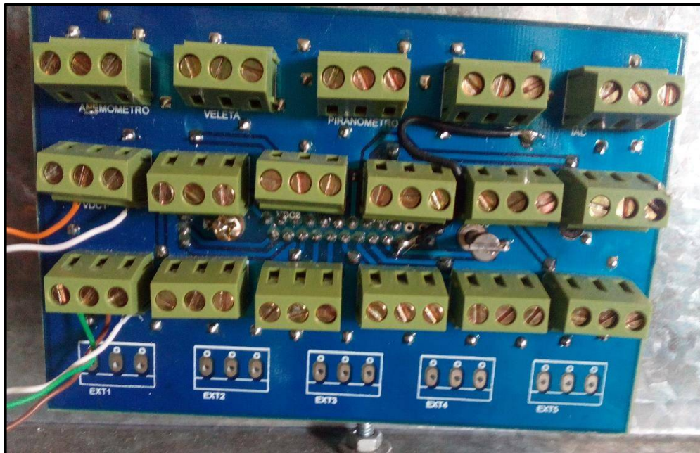
Figura 29. Placa de Conexiones del Datalogger
