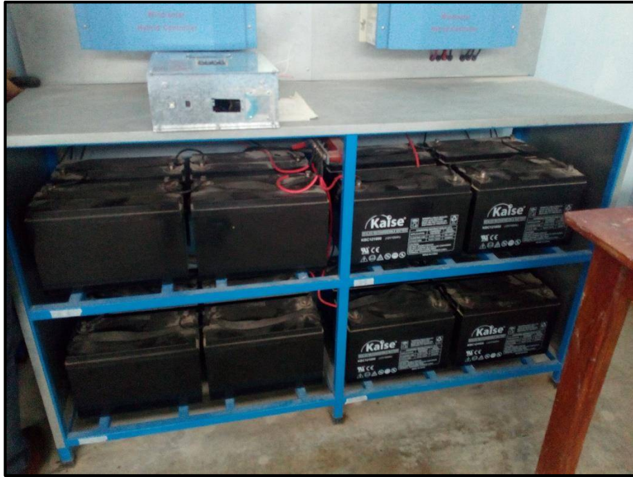
Figura 32. Instalación del Datalogger
