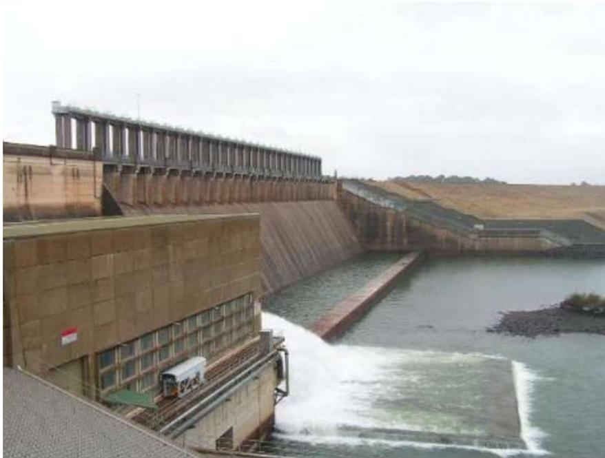
Fig. 2.14. Operación de un aliviadero controlado
