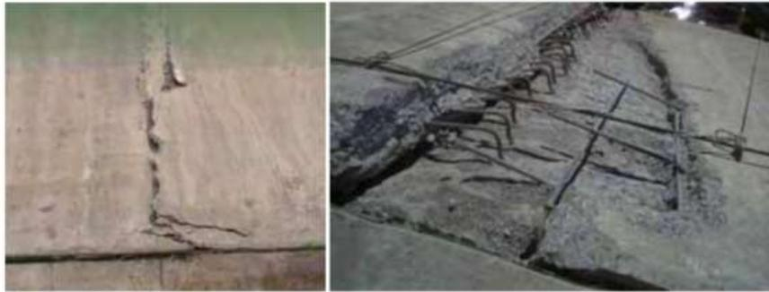
Fig. 2.10. Roturas presentadas en la cara de concreto de la CFRD Lesotho durante el primer llenado del embalse
