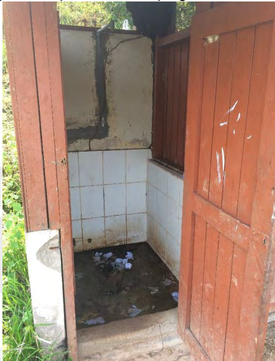
Fotografía del baño de la residencia de mujeres Fuente: elaboración propia
