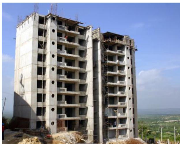
Figura 2.4: Ejemplo de edificación con sistema dual (Silva, 2016)
