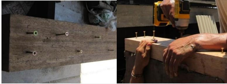
Figura 5.21: Fijación de la viga collar (Foto de la investigación SENCICO 2019 2017)
