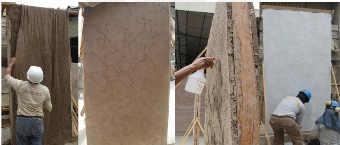
Figura 5.27: a) Curado con tela de yute mojada. b) Grietas por contracción por secado. c) Resanado con barbotina espesa. d) Acabado final con imprimante blanco (Fotos de la investigación SENCICO 2019 2017).
