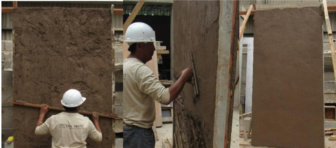
Figura 5.26: a) Aplicación de barbotina al muro para adherencia. b) Lanzamiento de la mezcla sobre el muro. c) aplicación de la primera capa de revestimiento. d) Regleado de la segunda capa. e) Frotachado final del muro. f) Acabado final (Foto de la investigación SENCICO 2019 2017).
