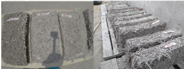
Figura 5.15: a) Colocado de los bloques después de su modulación. b) Apilado de bloques después del secado.
