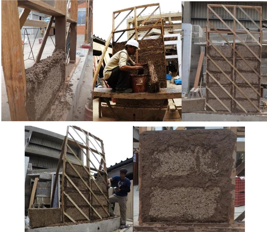
Figura 5.25: Colocación del relleno de bloques de 54 x 27 x 9 cm en el panel de madera (fotos propias)
