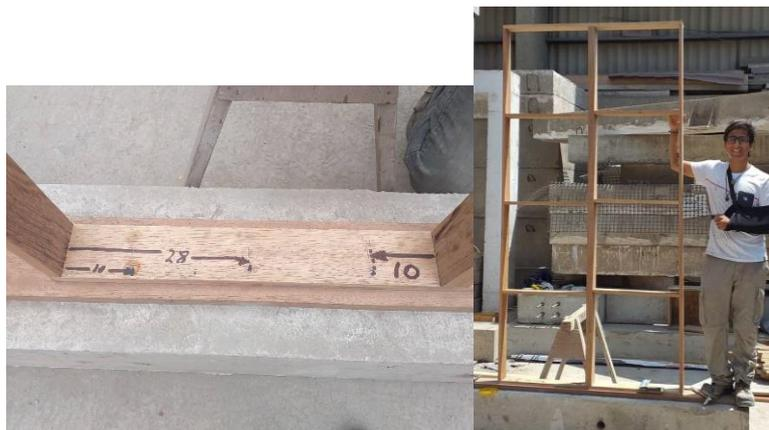
Figura 5.20: Montaje y fijación de los paneles sobre la viga de izaje (fotos propias)
