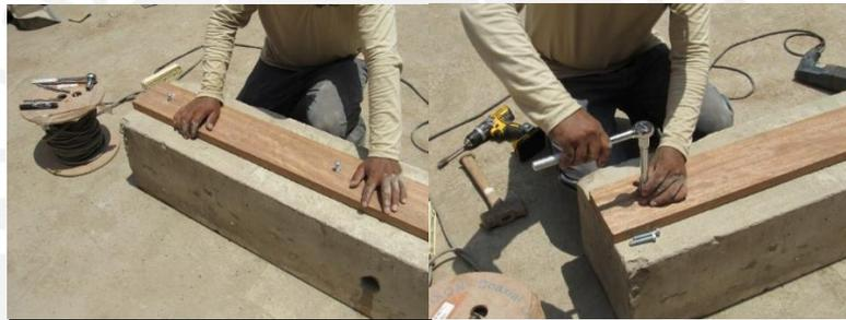
Figura 5.19: Fijación de la solera de zócalo sobre la cimentación (Foto de la investigación SENCICO 2019 2017)
