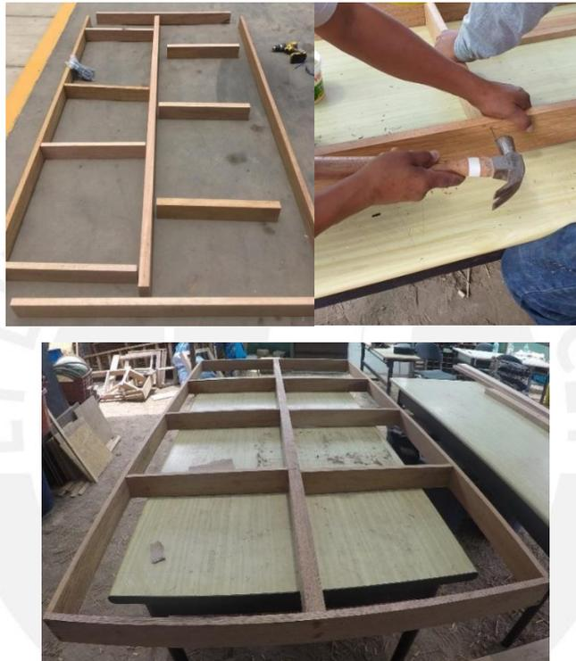
Figura 5.18: a) Pre-armado de los paneles en una superficie plana b) Clavado. c) Panel listo (foto propia)
