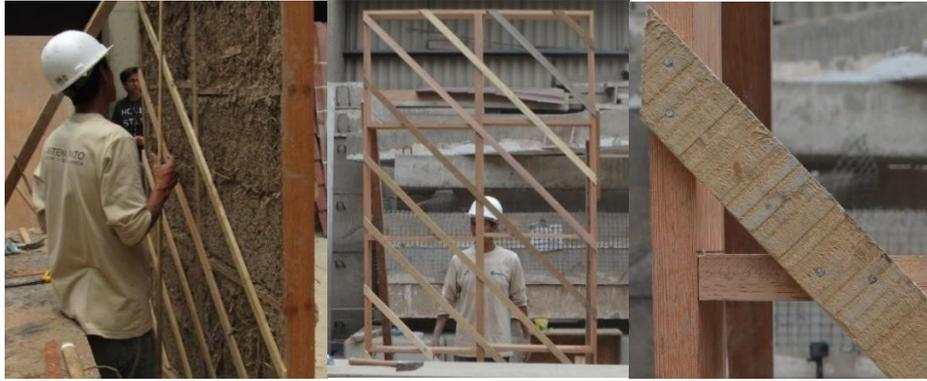
Figura 5.23: Fijación de la estructura auxiliar (Foto de la investigación SENCICO 2019 2017)
