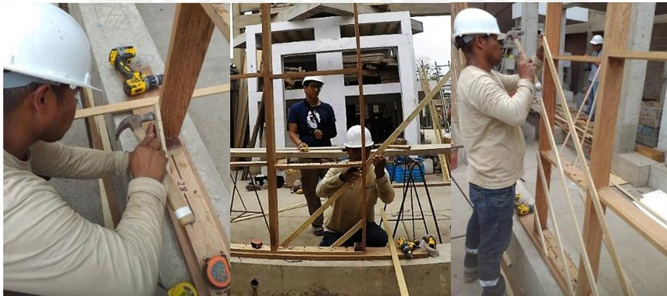
Figura 5.22: Fijación de la estructura auxiliar (Foto de la investigación SENCICO 2019 2017)
