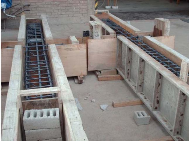
**Fig. 6.3** Habilitación del refuerzo y Encofrado de las Vigas de Cimentación
