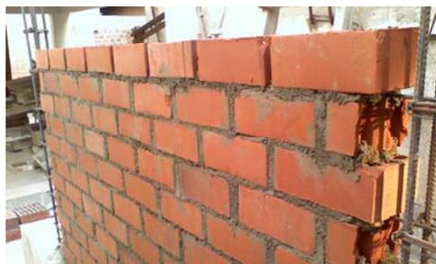
**Fig. 6.12** Junta vertical sin rellenar
