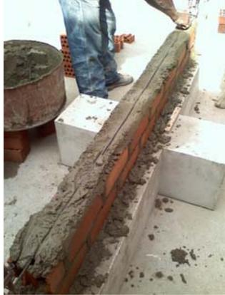
**Fig. 6.8** Colocación Refuerzo Horizontal
