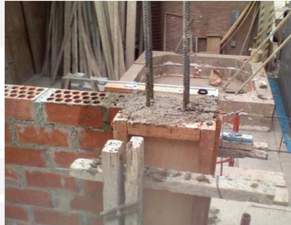
Fig. 6.14 Detalle de Final de las columnas
