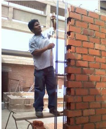
Fig. 6.13 Colocación de estribos de las Columnas
