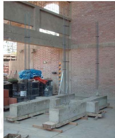
**Fig. 6.4** Vigas de Cimentación
