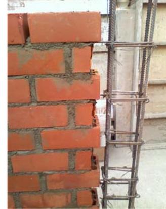
**Fig. 6.10** Conexión Muro Columna dentada
