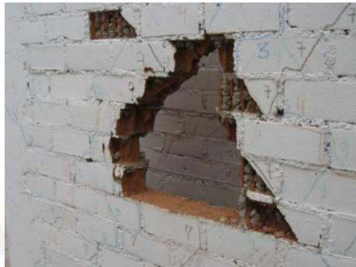
**Fig. 7.36** Estado final del Refuerzo del Muro
