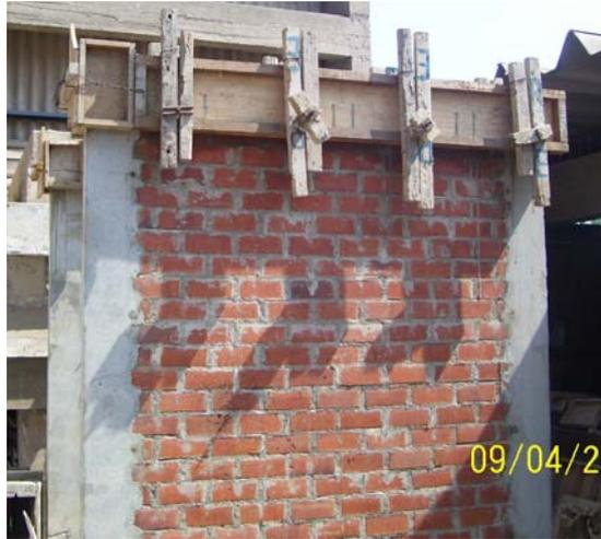
Fig. 6.15 Encofrado de Viga Solera
