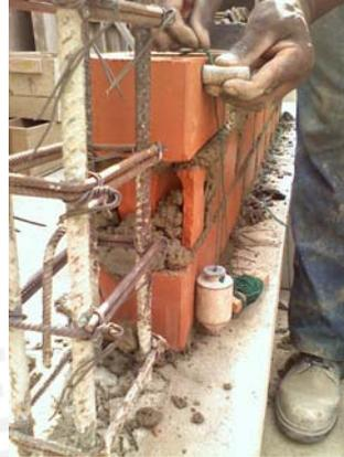
**Fig. 6.9** Anclaje Refuerzo Horizontal
