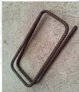
**Fig. 6.1** Estribo de Columnas
