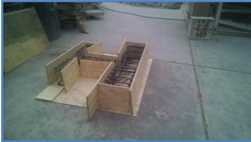
Fig. 4.6.- Presentación de las tapas del encofrado.
