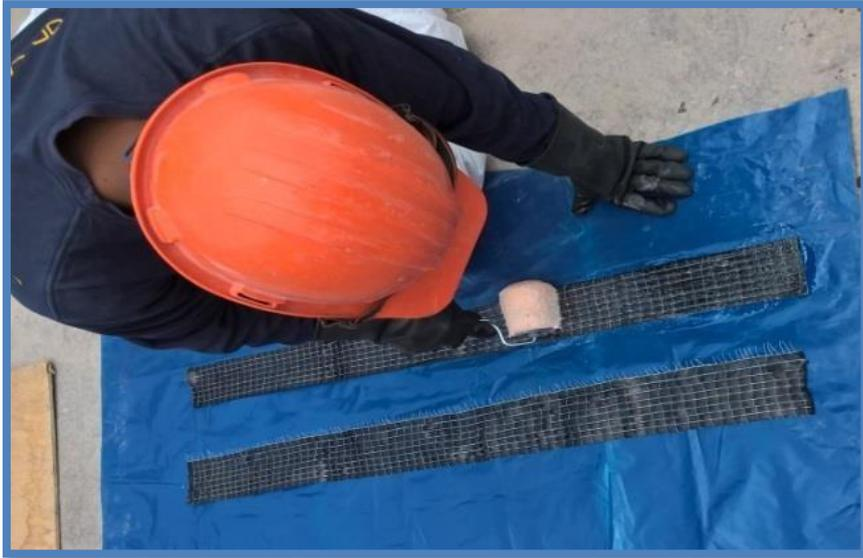
Fig. N° 4.14.-Aplicando Saturador tyfo.
