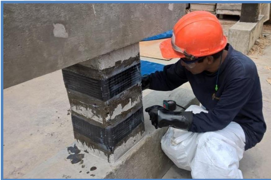
Fig. 4.15.-Aplicando capa final de epóxico tyfo espeso.
