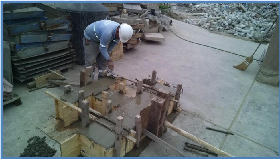
Fig. 4.10.- Acabado del vaciado de concreto.
