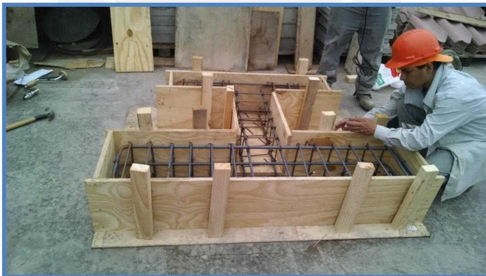
Fig. 4.7.- Encofrado del espécimen.
