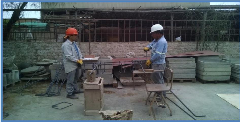
Fig. 4.4.- Armado de la viga de cimentación.
