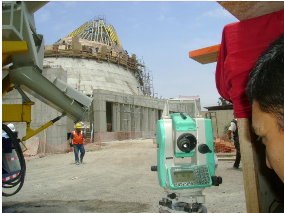
Figura 5.17. Supervisión del trabajo de topografía era constante y minucioso para asegurar la calidad de la curvatura de la cúpula. En la foto, el topógrafo está verificando la ubicación en 3D con la estación total (en el nivel +0.00) con ayuda de su asistente que se encuentra sosteniendo el prisma.
