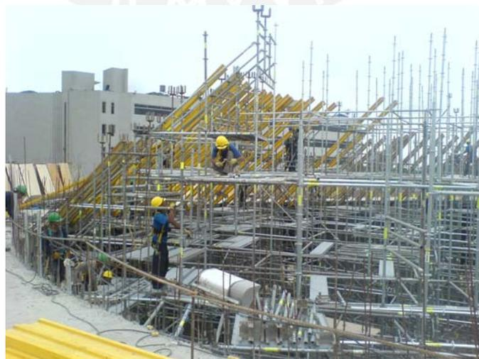
Figura 5.19. El trabajo de armado del andamio de Ulma fue hecho por personal especializado, se diferenció en obra por tener cascos amarillos y polos azules para una mejor supervisión y control.
