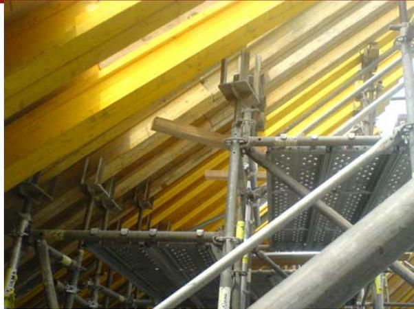
Figura 5.20. Vista interna del encofrado. Se implementaron plataformas rígidas de trabajo.
