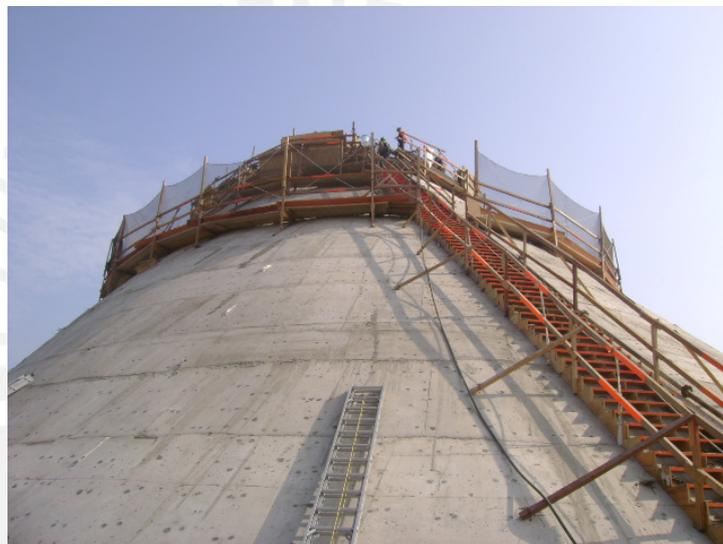
Figura 5.21. Vista desde la zona exterior. Se observa la escalera de acceso principal con sus respectivas barandas y línea de vida. También se observa una plataforma intermedia con malla de seguridad en caso de caídas.
