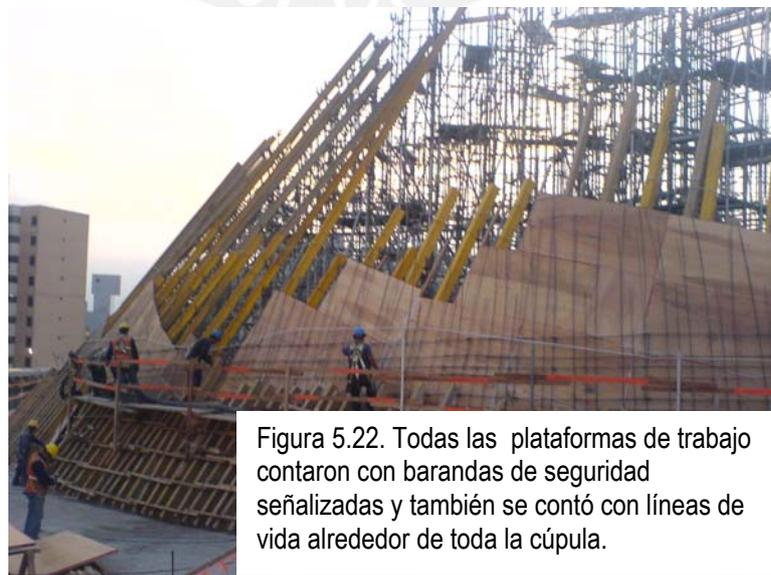
Figura 5.22. Todas las plataformas de trabajo contaron con barandas de seguridad señalizadas y también se contó con líneas de vida alrededor de toda la cúpula.
