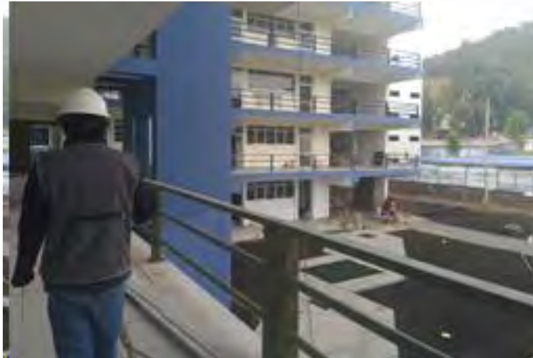
Figura 60. Producto único – construcción de proyectos
