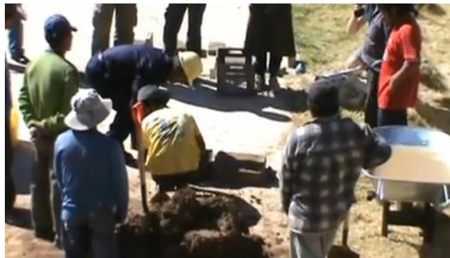
Figura 4.37. Taller de preparación de adobes en campo (Técnico especialista PUCP)
