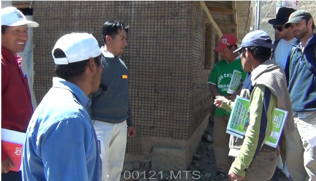
Figura 4.50. Conexión de malla con rafia – Vivienda Chocos
