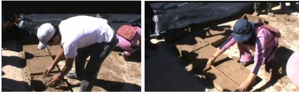
Figura 4.38. Fabricación de adobes en campo
