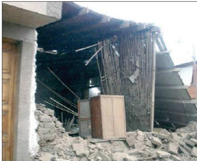
Figura 2.1. Muro de adobe sosteniendo techo (Elnashai, et al., 2008)
