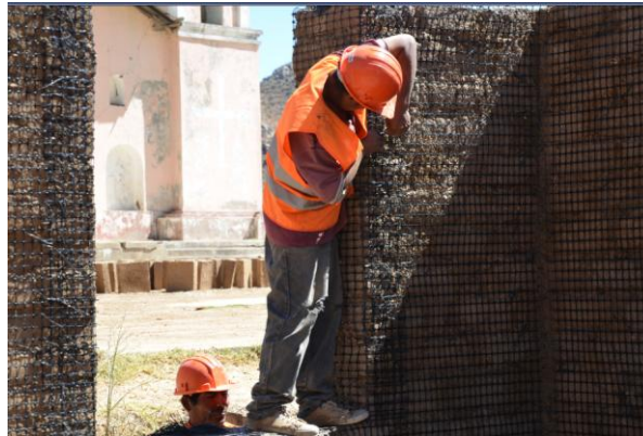
Figura 2.15. Instalación de la geomalla en muros de adobe
