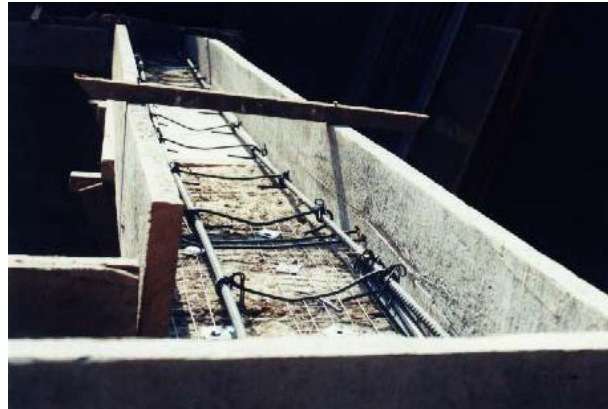
Figura 2.6. Encofrado de viga solera de concreto armado
