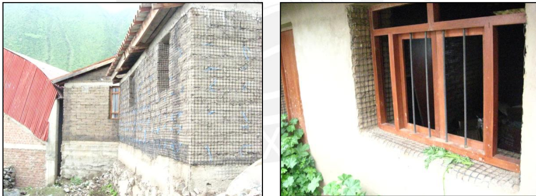
Figura 4.16. Viviendas reforzadas con geomalla en el distrito de Chocos.
