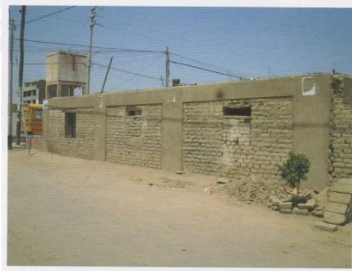
(b) Casa reforzada con malla electrosoldada
