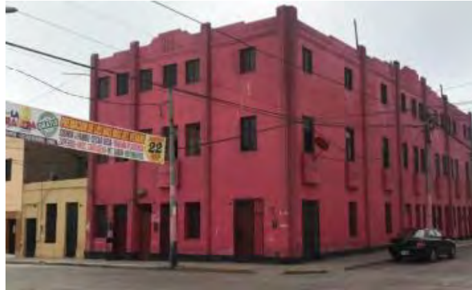
Edificio de vivienda en esquina de Atahualpa con Miroquesada, mayo 2018. Fuente: Elaboración propia, 2018.
