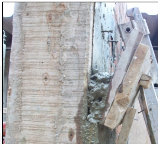
Fig. 5.15 Encofrado en forma de embudo.
