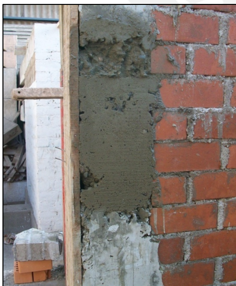
Figura 5.16 Apariencia de la columna luego de retirar el encofrado para la mezcla fluida.
