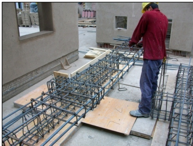
Fig. 5.3 Habilitación del acero y colocación sobre paneles de madera.
