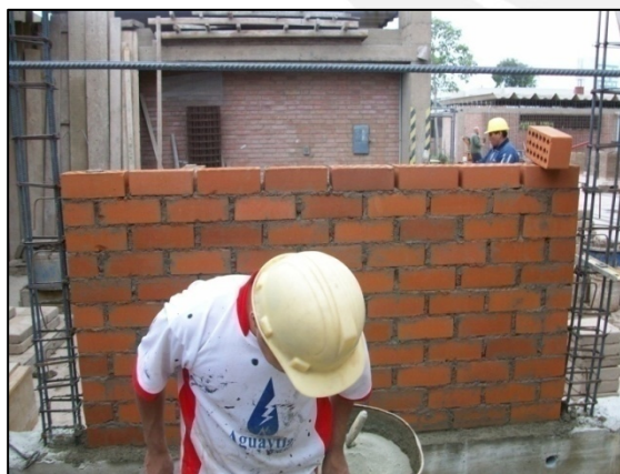
Fig. 5.8 Primera jornada de asentado de ladrillos.
