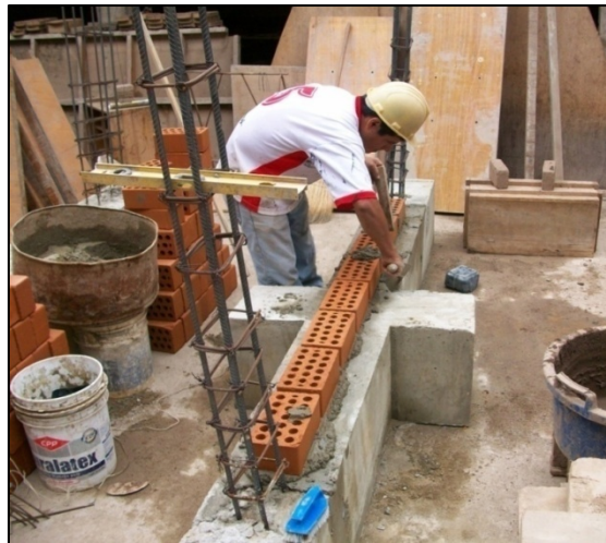
Fig. 5.7 Construcción de primera hilada.
