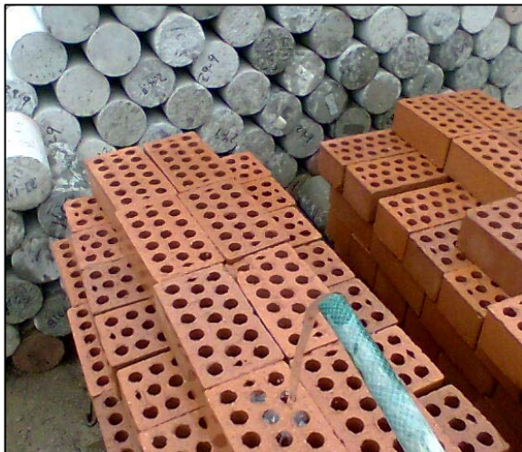
Fig. 5.6 Humedecimiento de las unidades de albañilería.
