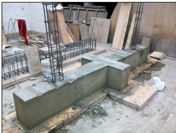
Fig. 5.5 Viga de cimentación.
