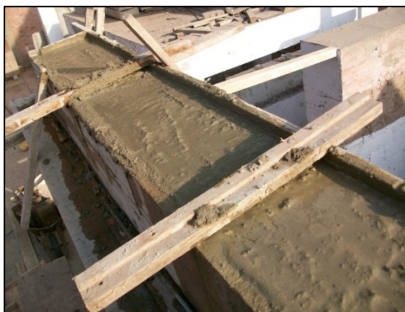
Fig. 5.17 Construcción de la viga solera.
