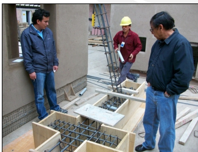
Fig. 5.4 Encofrado de viga de cimentación.
