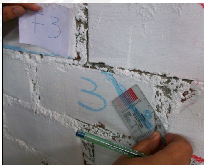
Fig. 7.2 Fisura producida en la fase 3, grosor de la fisura 0.41 mm.
