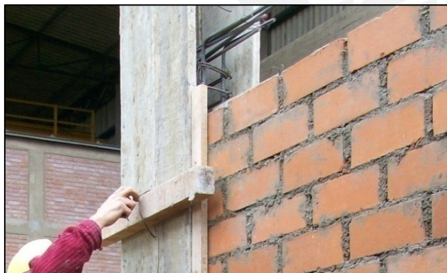
Fig. 5.11 Refuerzo vertical interior doblado a la misma altura que el refuerzo vertical exterior
