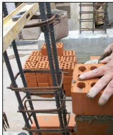
Fig. 5.12 Colocación de estribos en columna.
