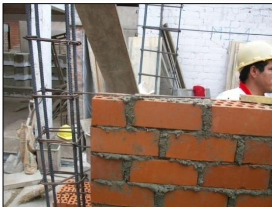
Fig. 5.10 Colocación de chicotes cada dos hiladas.
