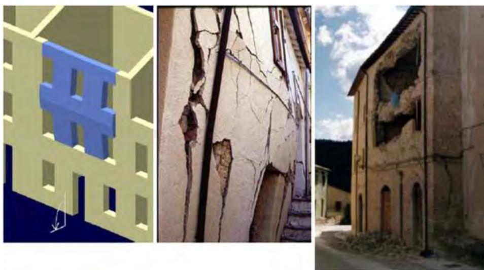
*Figura 2.6. Identificación de mecanismos de flexión vertical – esquema y fotos. (ReLUIS; s/f)*
