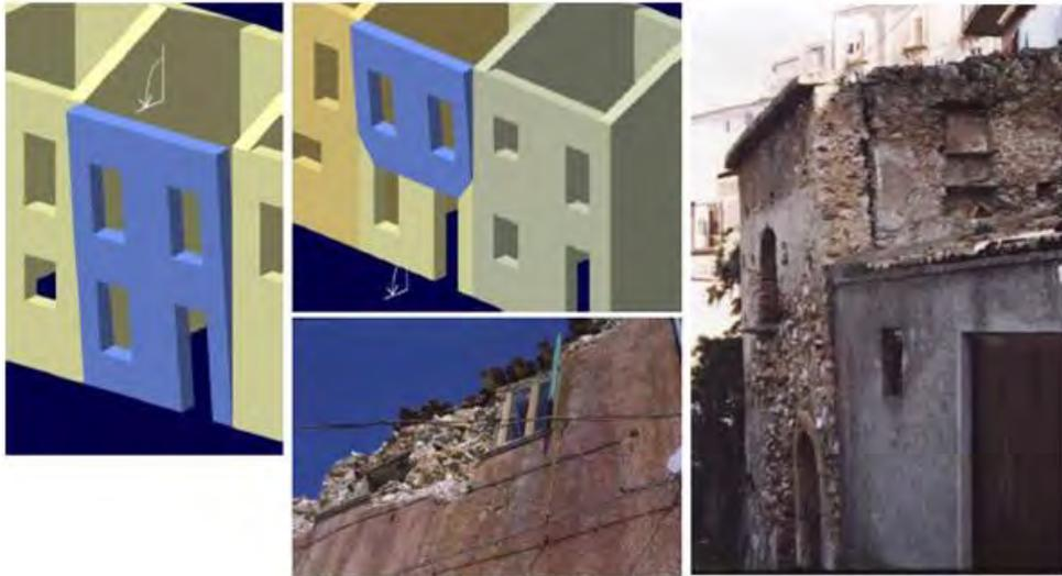
Figura 2.2. Identificación del mecanismo de volteo simple – esquemas y fotos (ReLUIS; s/f)
