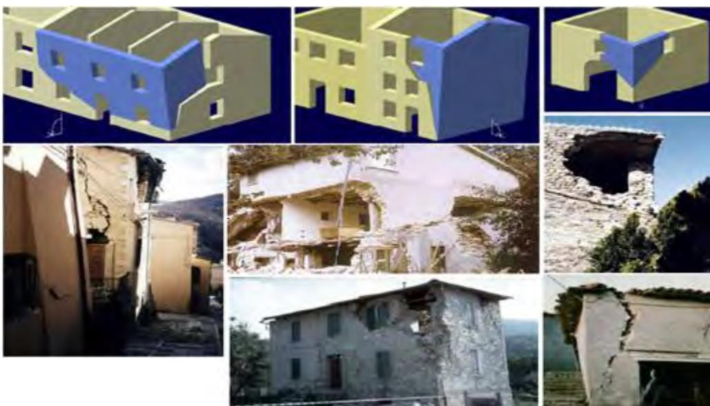
*Figura 2.4. Identificación del mecanismo de volteo compuesto – esquemas y fotos (ReLUIS; s/f).*
