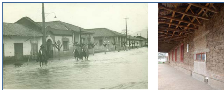
Fig. 46: Ascenso de agua por capilaridad a través del muro patrón.
