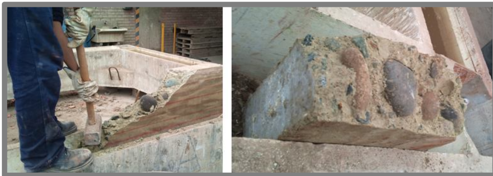
Fig. 45: Derrumbe del bloque de concreto ciclópeo.
