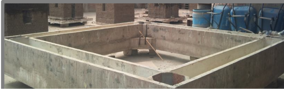
Fig. 4: Canal usado para el ensayo de inundación de muros
