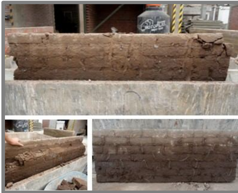
Fig. 56: Estado del sobrecimiento de adobe tarrajado pasado el ensayo.
