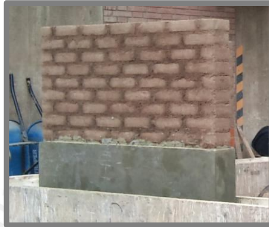
Fig. 11: Muro de adobe con sobrecimiento tarrajeado (MT)
