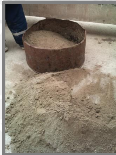
Fig. 2: Mezcla de cemento, arena fina y agua para formar el tarrajeo del muro MT.
