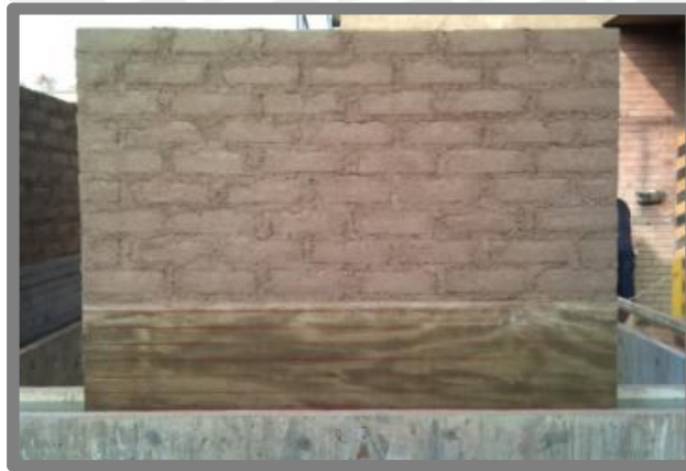
Fig. 15 Muro de adobe con sobrecimiento de concreto ciclópeo (MC)
