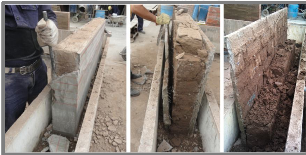
Fig. 42: Proceso de demolición del muro de adobe tarrajeado.
