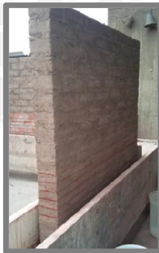
Fig. 7: Vista del muro patrón antes del ensayo de inundación.
