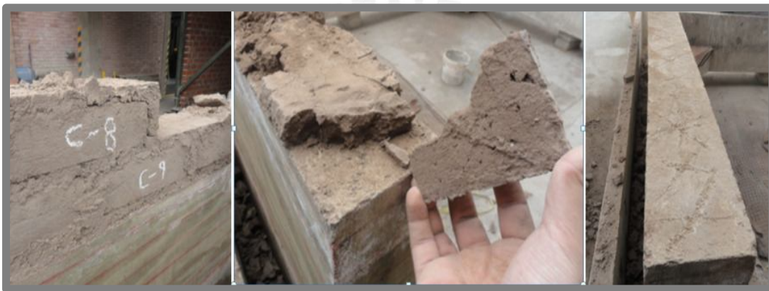
Fig. 44: Últimas hiladas de adobe antes de llegar al bloque de sobrecimiento ciclópeo.
