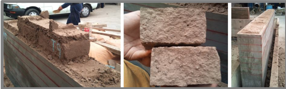
Fig. 41: Se aprecia la última fila de adobe seca antes de ingresar a la altura de adobe tarrajeado.
