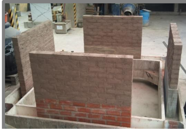
Fig. 6: Vista superior de los distintos muros construidos sobre el canal.
