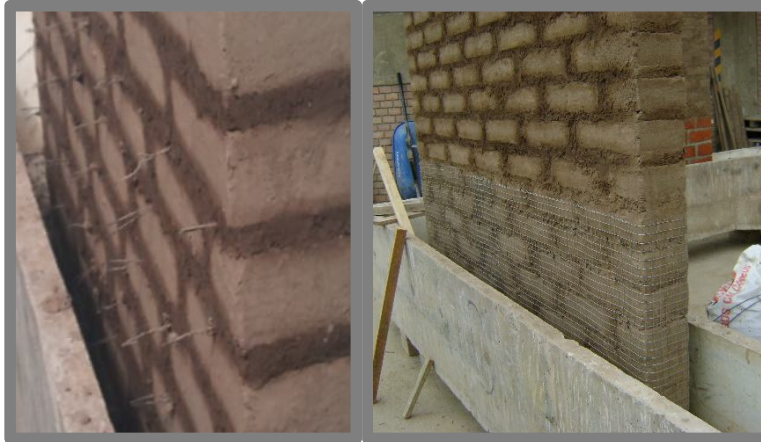
Fig. 13: Malla electrosoldada fijada por ambas caras por el alambre #8 pasante.
