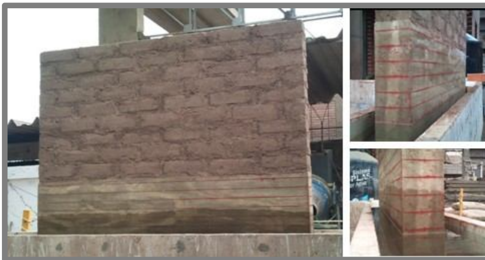
Fig. 43: Ensayo de inundación del muro con sobrecimiento ciclópeo MC(Izq. & Der. inferior- Día 2, Der. superior – Día 10)
