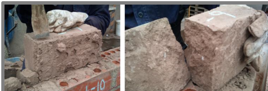
Fig. 38: Vista de la última hilera de adobes encima del sobrecimiento de ladrillos
