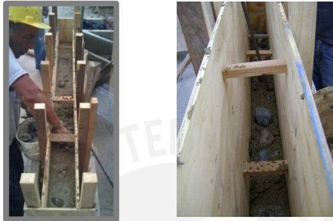
Fig. 14 Elaboración del sobrecimiento de concreto ciclópeo.
