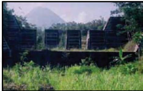
Figura 48. Presa tipo ranurada. – SABO dam Abierta Boyong River, Indonesia
