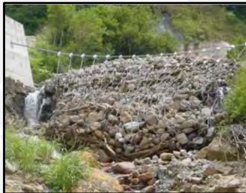
Figura 51. Presa con red metálica. Mount Tateyama, Japan (Extraído de Mizuyama, 2008)
