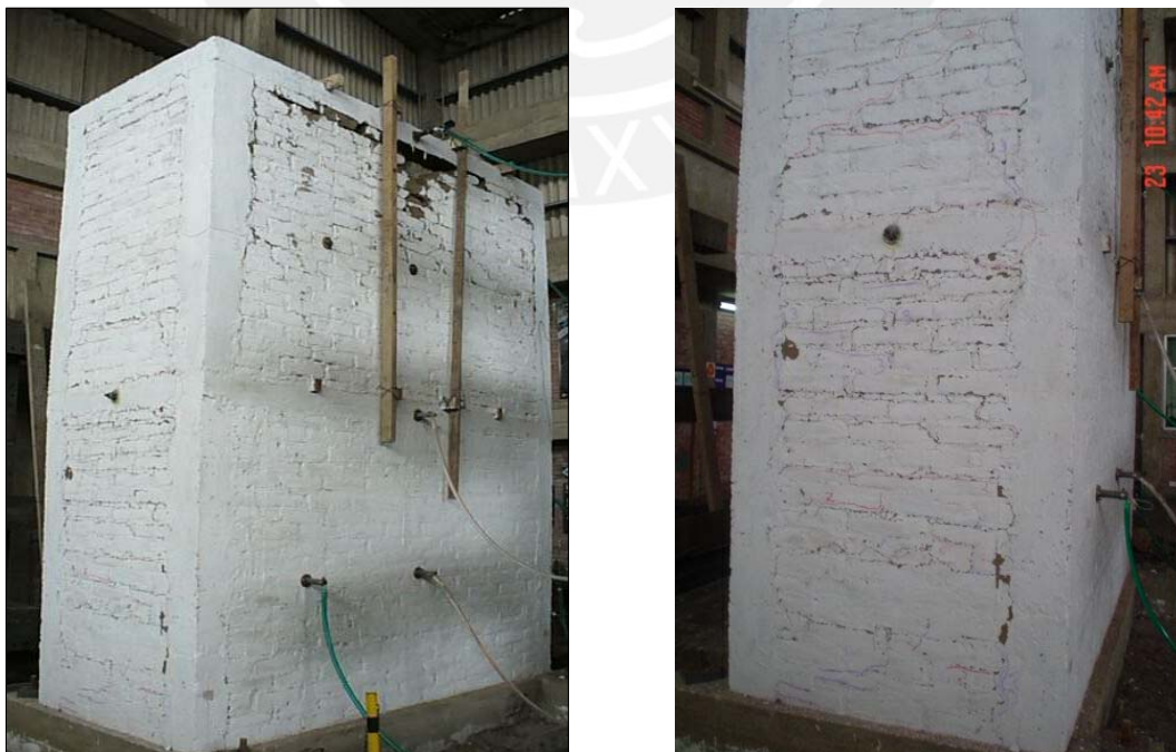
Fig. 6.10 Fase 3: Fisuras en muros de corte
