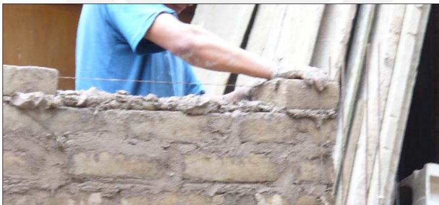
Fig. 4.5 Asentado de unidades de adobe con mortero de barro
