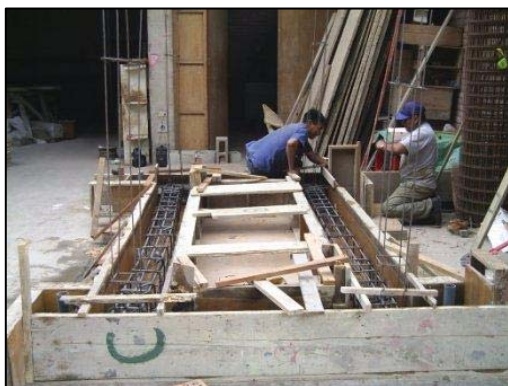
Fig. 5.1 Secuencia de la construcción de la cimentación del módulo
