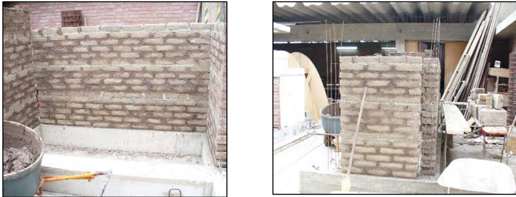
Fig. 5.3 Secuencia de construcción muros del primer piso
