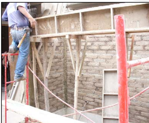
Fig. 5.5 Secuencia del proceso constructivo empleado en las soleras
