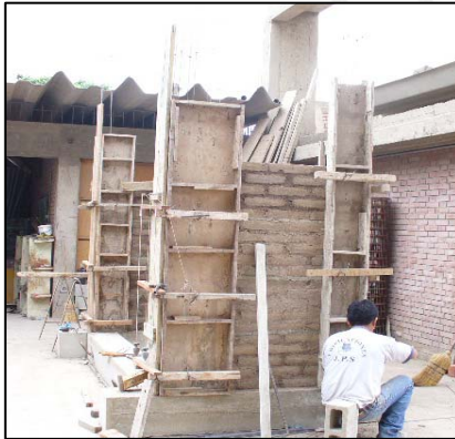
Fig. 5.4 Secuencia de construcción de las columnas de confinamiento
