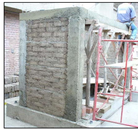
Fig. 5.5 Secuencia del proceso constructivo empleado en las soleras
