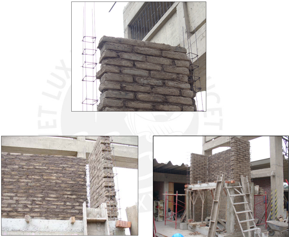
Fig. 5.6 Construcción de los muros del segundo piso
