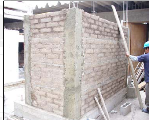
Fig. 5.4 Secuencia de construcción de las columnas de confinamiento
