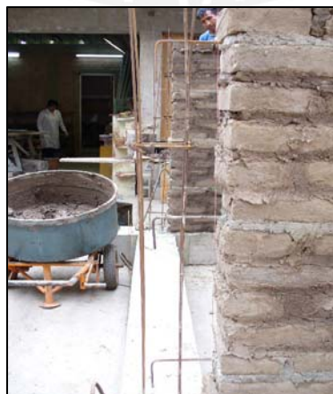
Fig. 5.2 Refuerzo horizontal continuo anclado en las columnas
