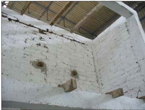
Fig. 6.7 Fase 2: Fisura en muro de flexión de segundo piso
