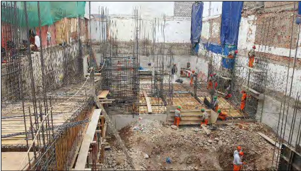
Figura 27: Estado de la Obra al 08/09/16 | Fuente: Propia
