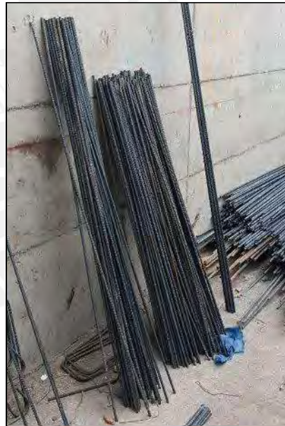
Figura 32: Varillas cortadas para habilitar estribos | Fuente: Propia
