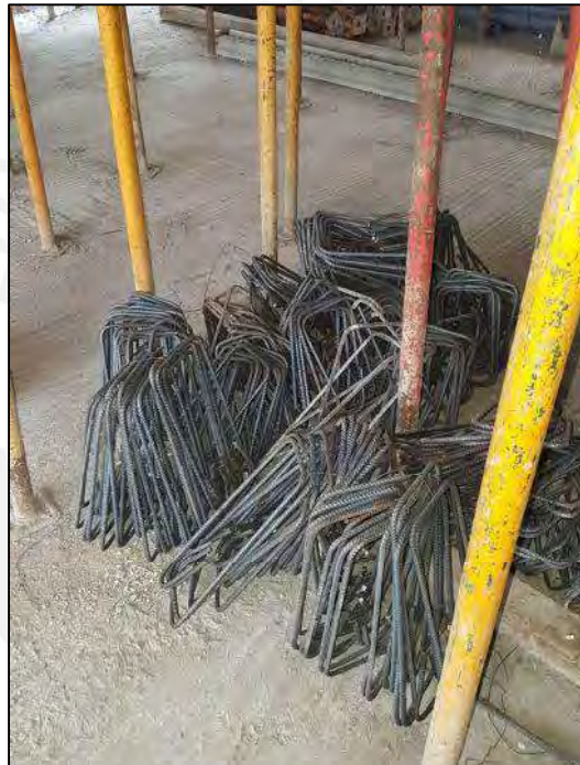
Figura 34: Estribos almacenados por 2 días | Fuente: Propia
