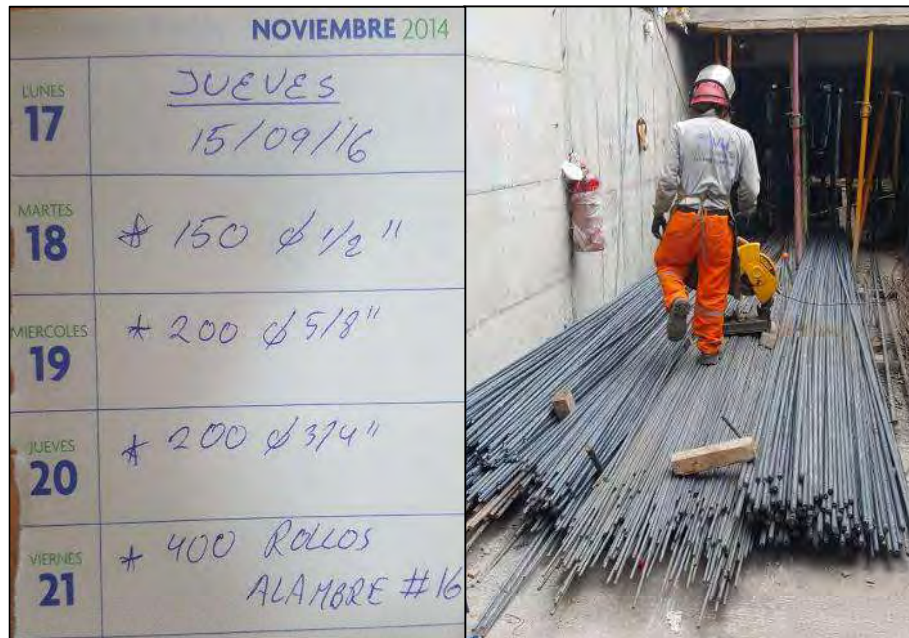
Figura 28: Requerimiento de materiales por el jefe de cuadrilla y zona de acopio de material comprado | Fuente: Propia
