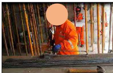
Figura 29: Habilitado de estribos | Fuente: Propia
