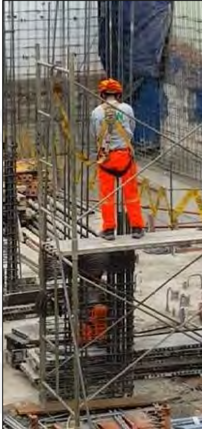
Figura 33: Dos personas en la colocación de varillas de la columna C-6 | Fuente: Propia
