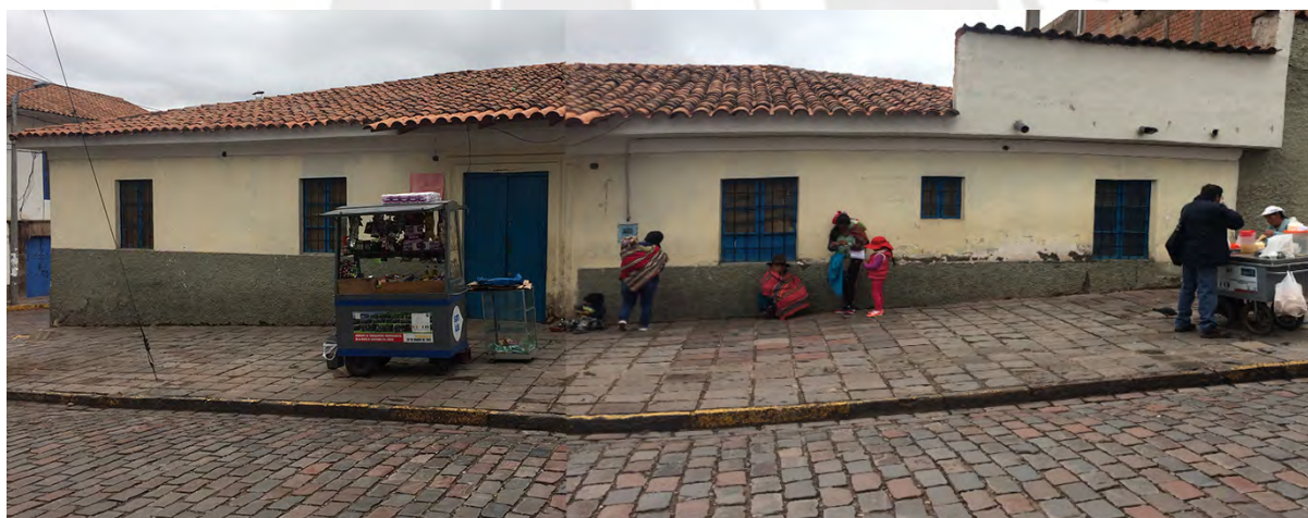
Figura 4. Fachada del C.S “Siete Cuartones”. Fotografía propia. Tomada en febrero 2018.
