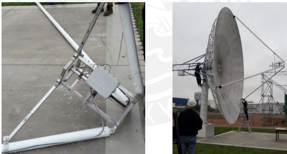
Figura 49: Montaje del soporte del alimentador
