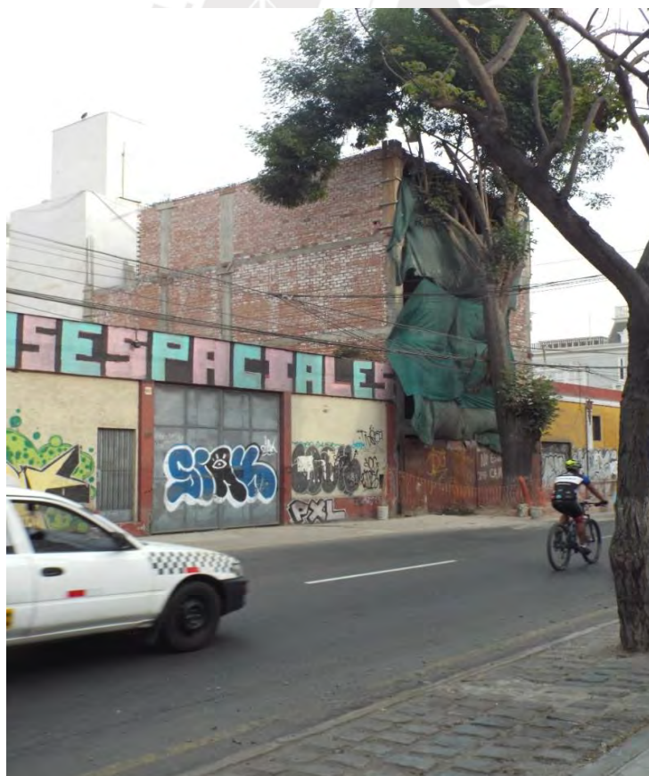
Figura A5. Avenida San Martín entre la avenida Sáenz Peña y el jirón Martínez de Pinillos
