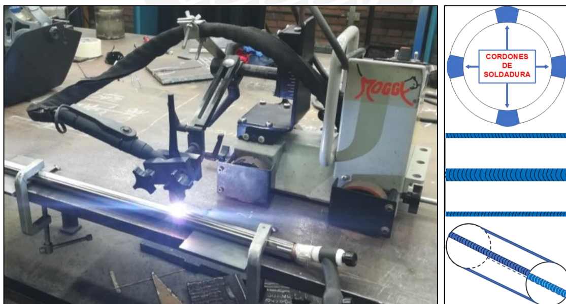
Figura 12. Montaje de tubería durante ejecución de las zonas fundidas y esquema de distribución de cordones de soldadura.
