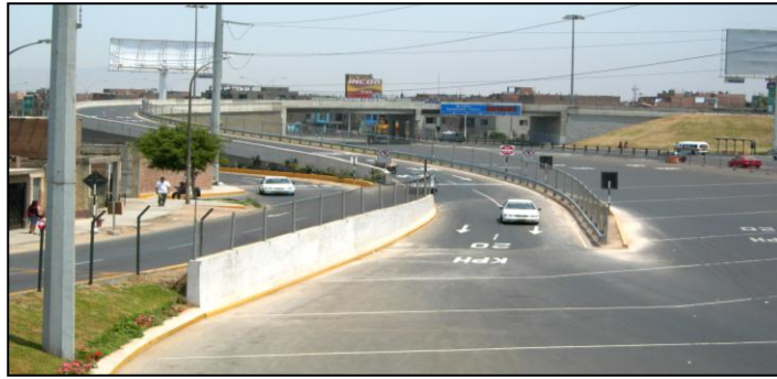
Figura 2.12. Muro de Suelo Reforzado con Bloques de Concreto. By Pass Av. Quilca con Av. Faucett en la Vía Expresa del Callao. Lima, Perú. (Centurión, 2006).
