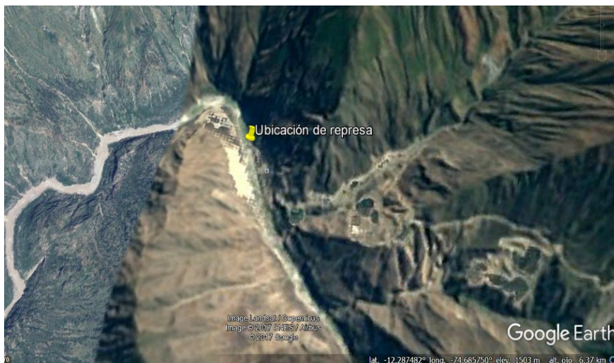
Figura 19. Vista aérea del lugar en donde se construirá la presa de enrocado (Google Earth, consultado: 28 agosto 2017)
