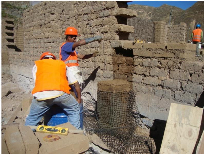
**Figura 6.27** Acabado de muro en forma de engranaje para la conexión con el contrafuerte.
