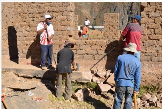
Figura 6.1 Demolición de vereda y jardín.
