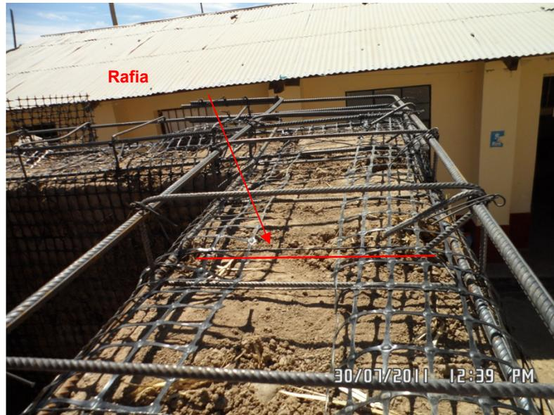
**Figura 6.17** Detalle de instalación de la geomalla dentro del núcleo de la Viga Collar.
