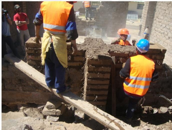
**Figura 6.26 Asentado de muro y contrafuerte en simultáneo.**
