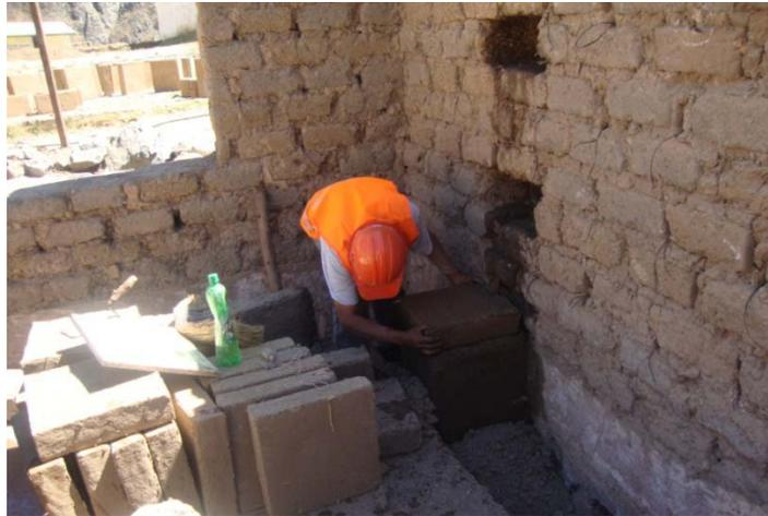
**Figura 5.25 Asentado de los adobes del contrafuerte.**
