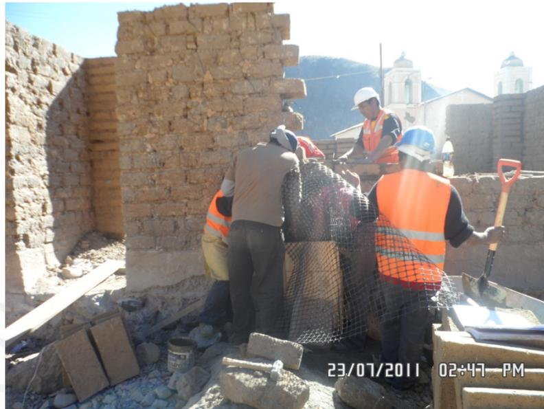
**Figura 6.19** Instalación de geomalla en cimentación de contrafuerte.
