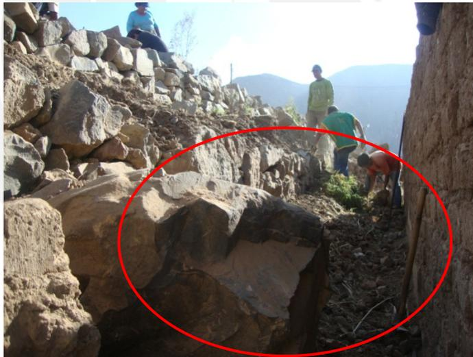
Figura 6.5 La distancia de la roca al futuro contrafuerte no excedería los 2cm. El peligro es inminente.
