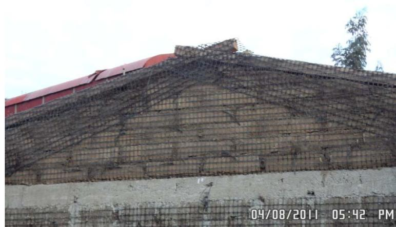
**Figura 6.18** Acabado de sujeción de la geomalla en tímpanos.
