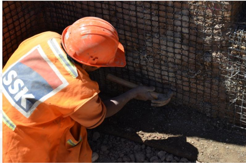
**Figura 6.14 Control con clavos de las ondulaciones de la geomalla colocada**
