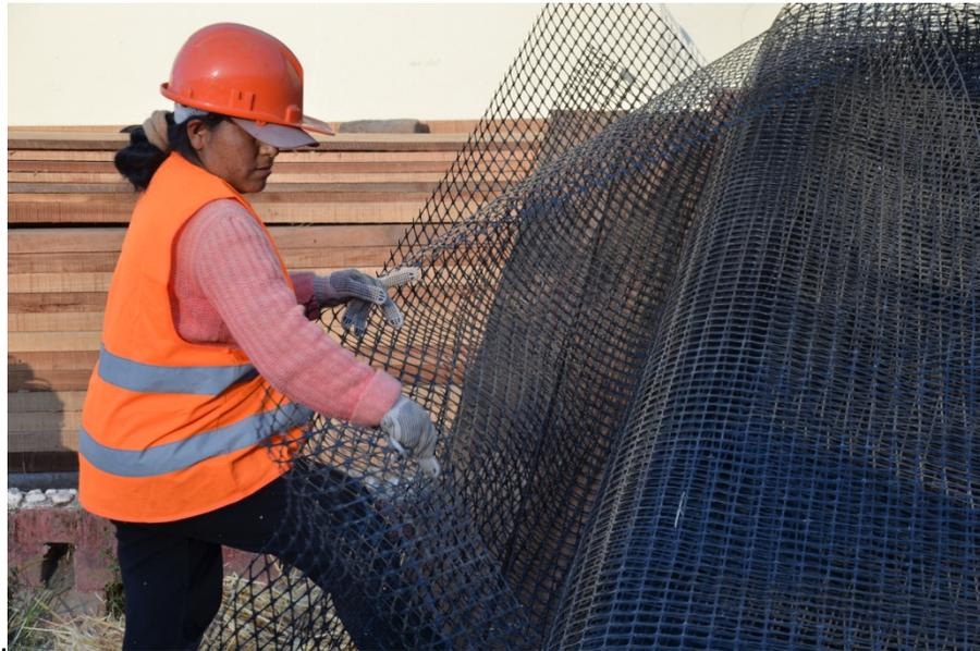
**Figura 6.10 Almacenamiento de cortes de geomalla.**
