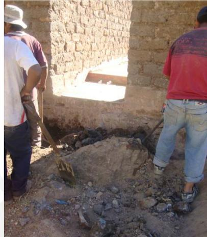
Figura 6.2 Interrupción de la excavación a causa de la roca.
