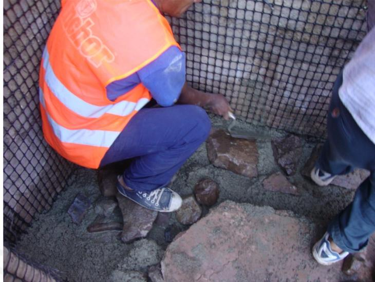
**Figura 6.9 Vaciado de cimentación de geomalla en base a mortero de arena-cemento y piedras grandes.**
