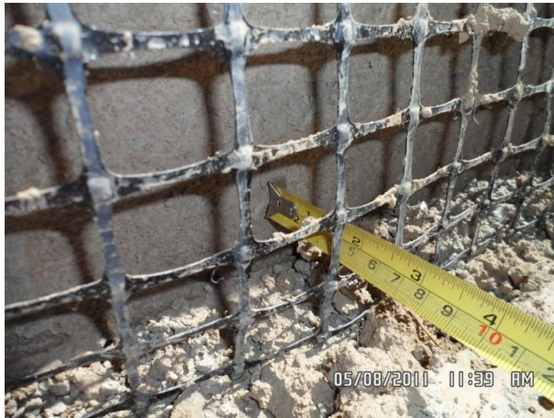
**Figura 6.15 Ondulaciones excesivas en el encuentro muro – cimentación de geomalla.**
