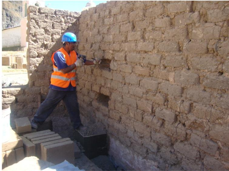
Figura 6.22 Corte o picado de dientes (mitades de bloques de adobe) para la conexión muro-contrafuerte.
