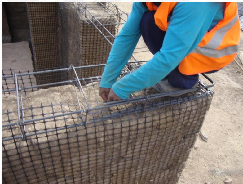
**Figura 6.16 Colocación de la geomalla dentro de la Viga Collar**
