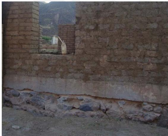
Figura 6.7 Exposición de la pirca del muro a causa del desnivel con el patio.
