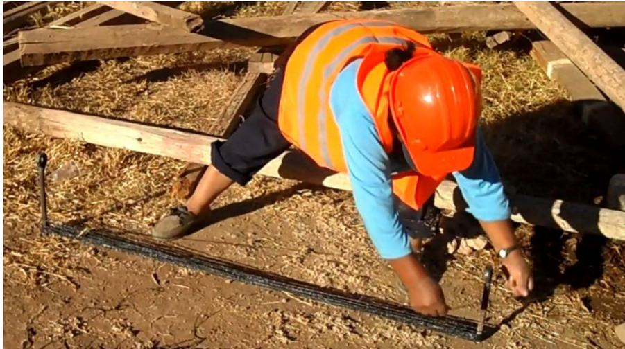
Figura 6.12 Técnica de corte de rafia, longitud 1.40m
