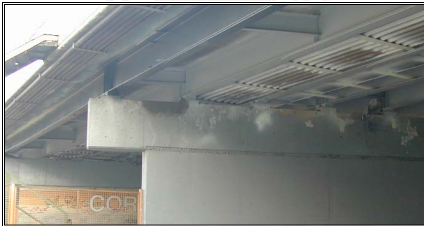
Figura Nº 1.15. Vigas y conexiones de acero estructural del Puente Canaval y Moreyra.
