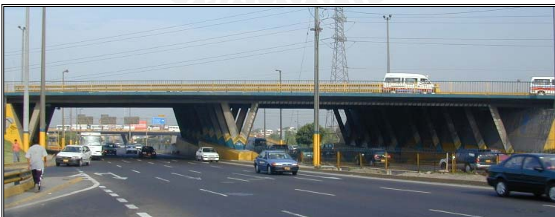
Figura Nº 1.16. Puente continuo curvo Coronel Francisco Bolognesi, sobre la Av. Javier Prado.
