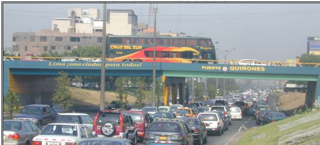
Figura N° 1.24. Puente continuo de dos tramos (Puente Quiñones), sobre la Av. Javier Prado.
