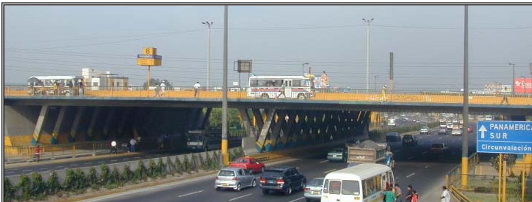
Figura N° 1.19. Puente continuo recto, sobre la Av. Javier Prado (Puente Circunvalación).
