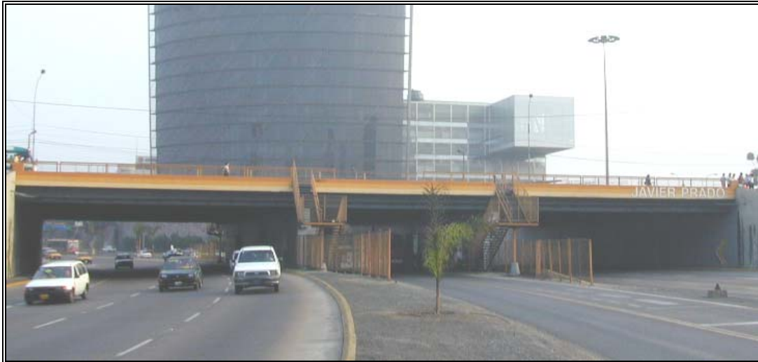
Figura N° 1.11. Puente continuo de concreto armado de tres tramos (Puente Javier Prado), sobre la Vía Expresa.
