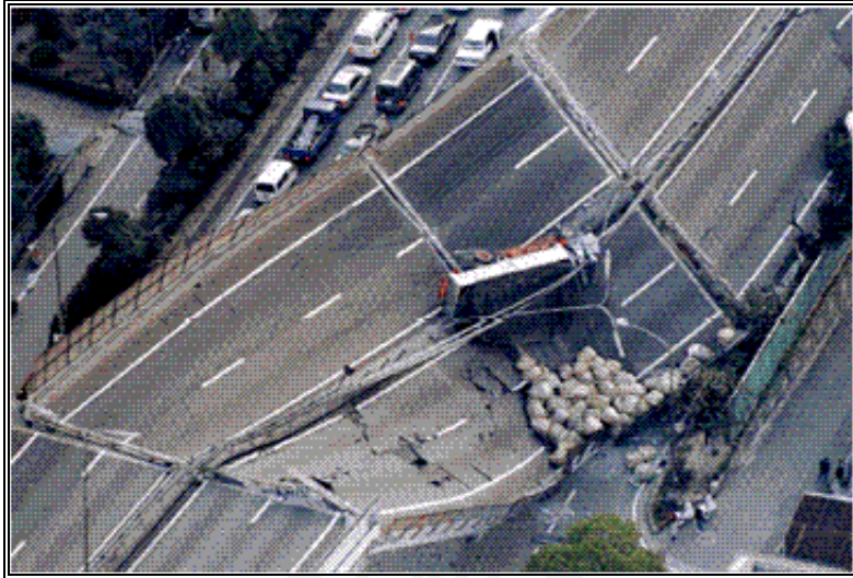
Figura N° 1.5. Colapso de puente. Terremoto de Kobe (17/01/1995).
