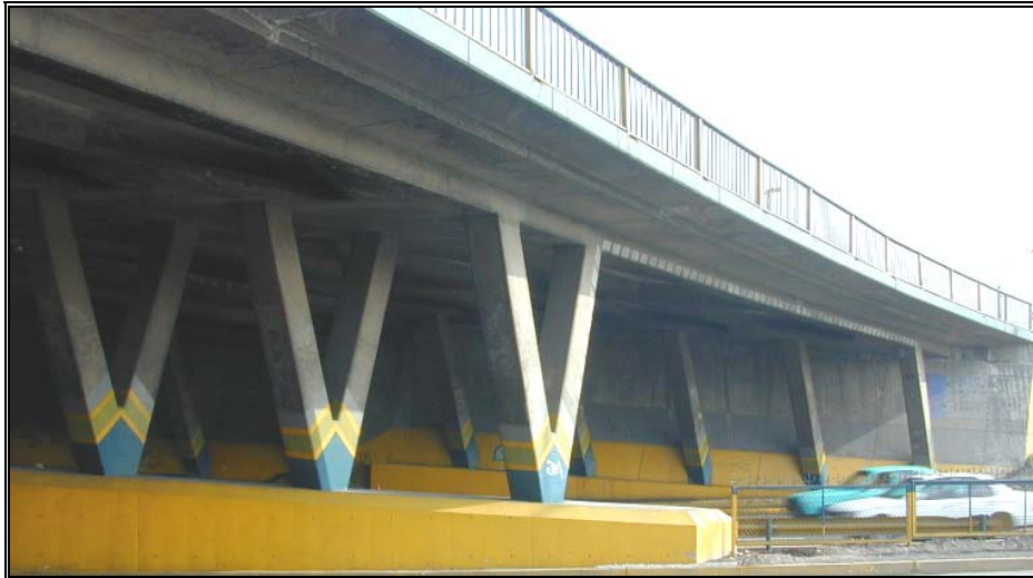
Figura N° 1.17. Puente continuo curvo Coronel Francisco Bolognesi, se observa columnas en forma de V, con poca rigidez transversal.
