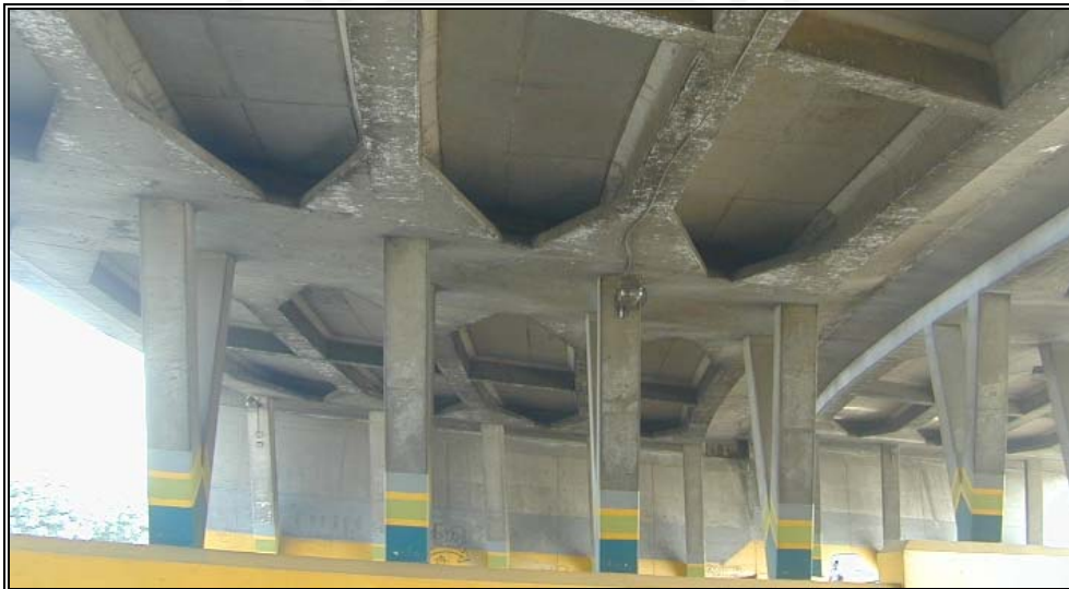
Figura N° 1.18. Subestructura del puente curvo Coronel Francisco Bolognesi, se muestra sección cajón en apoyo interno.
