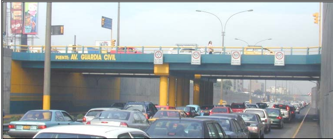
Figura N° 1.23. Puente continuo de dos tramos (Puente Av. Guardia Civil), sobre la Av. Javier Prado.
