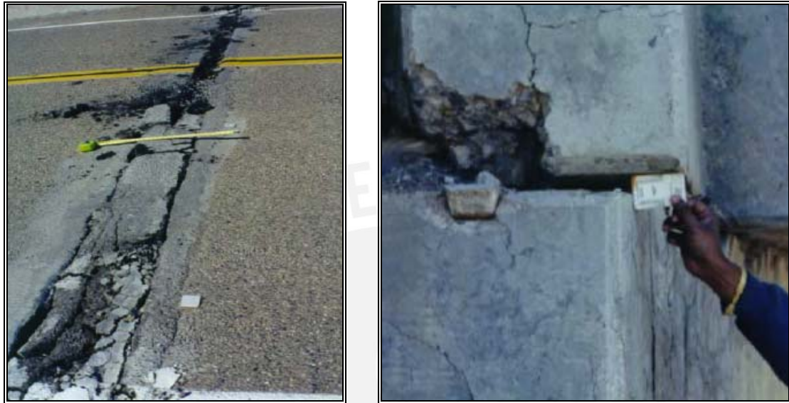
Figura N° 4.3. Desplazamientos que comúnmente ocurren en puentes después de un evento sísmico [Ref. 3].
