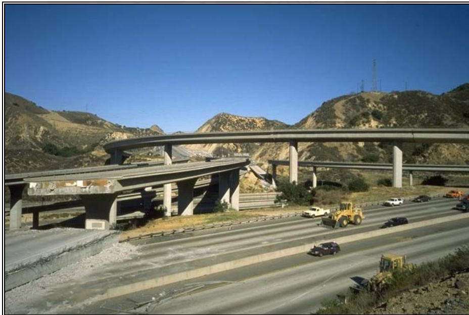
Figura N° 1.4. Colapso de puente. Terremoto de Northridge (17/01/1994).
