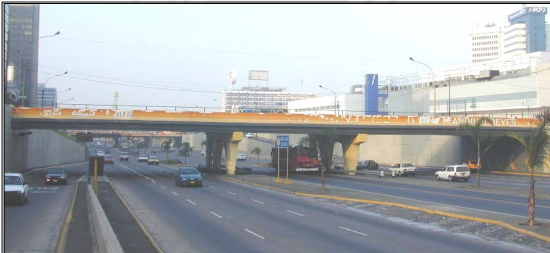
Figura N° 1.12. Puente continuo de concreto armado de tres tramos (Puente Andrés Reyes), sobre la Vía Expresa.
