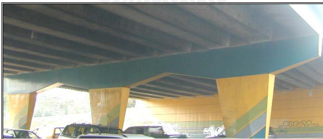
Figura N° 1.25. Pilares del Puente Quiñones, sobre la Av. Javier Prado. Se observa una sección reducida en la base del pilar, similar al del puente Andrés Reyes.
