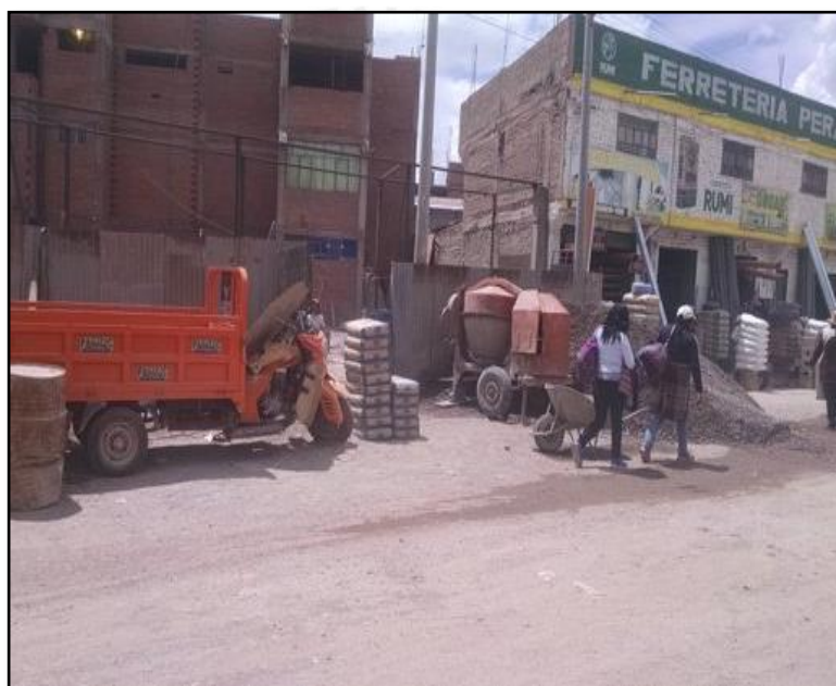
Gráfico N°2.4: Autoconstrucción de vivienda-comercio en zona central de la ciudad.
