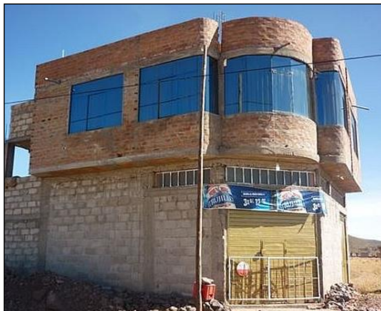
Gráfico N°2.5: Autoconstrucción de vivienda-comercio en zona periurbana.
