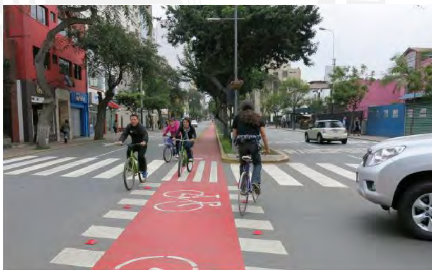
Figura 14: Pavimento de color rojo en intersección en Lima
