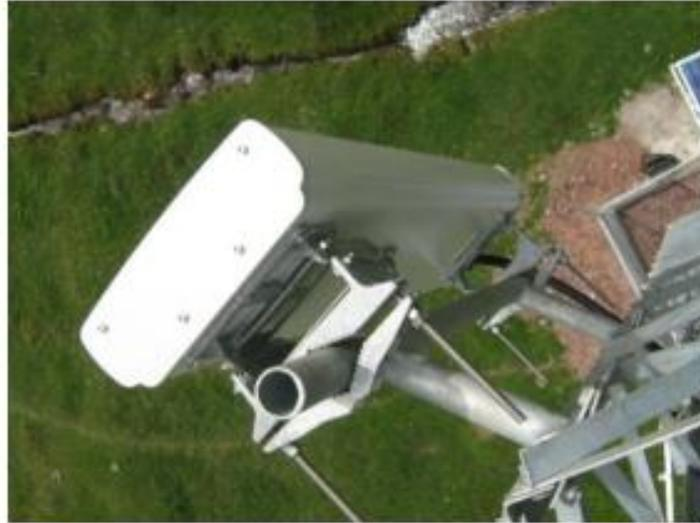
**Figura 5-8: Antena Sectorial en la Torre**
