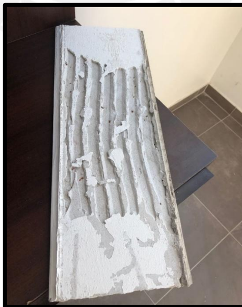
Figura 41 Pieza de cerámico desprendida en terraza
