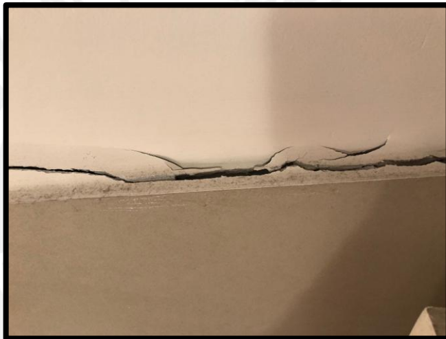
Figura 40 Pieza de cerámico cajoneada en baño principal
