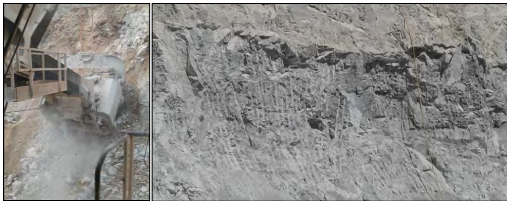
Figura 4.12 Pala eléctrica perfilando el frente de carguío y cómo queda
