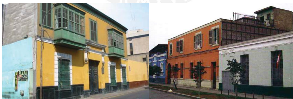
Figura 2.12. Construcciones de adobe y quincha del centro de Lima (Tomado de Gutiérrez & Manco, 2006; PNUD, 2008)
