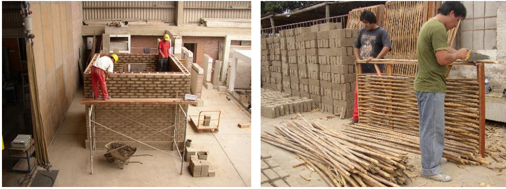
Figura 5.2. Construcción de mampostería de adobe y paneles de quincha (respectivamente) (Tomado de Silva et al., 2006)
