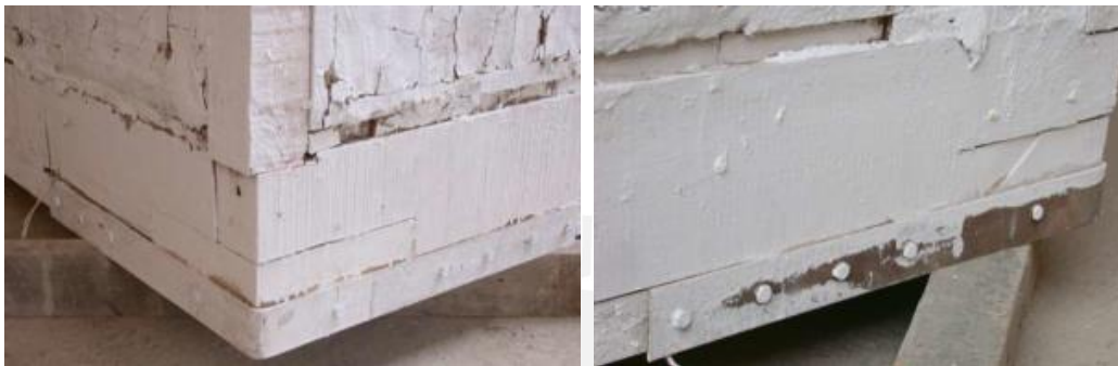
Figura 5.7. Refuerzo externo con ángulos metálicos en el Módulo M2 (Tomado de Sánchez, 2006)
