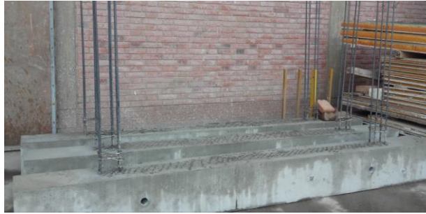
e) Curado de las vigas de cimentación
