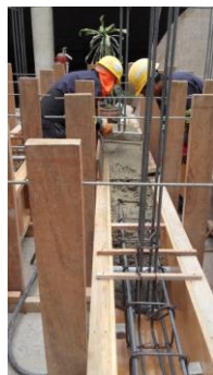
c) Vaciado de concreto
