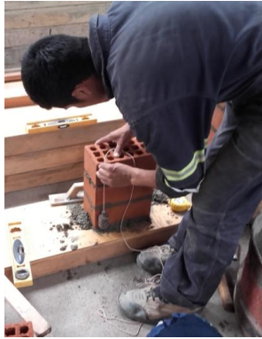
c) Verificación de la verticalidad con la plomada
