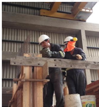
b) Vaciado de concreto
