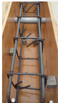
a) Colocación de los dados de concreto y tubo de PVC en el encofrado
