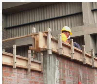
b) Vaciado de concreto
