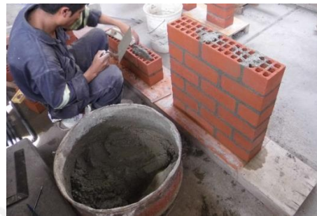
b) Colocación de mortero en la segunda hilada del murete
