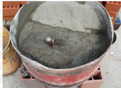
b) Mezcla del cemento y la arena con agua
