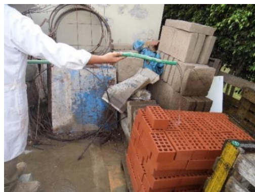
b) Regado de las unidades un día antes de la construcción de las pilas
