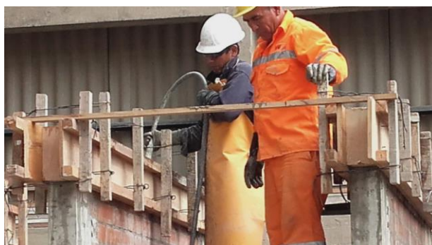
c) Vibrado del concreto vaciado en las vigas soleras
