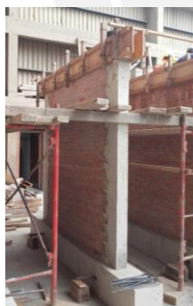
a) Encofrado de las vigas soleras
