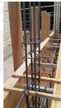
b) Refuerzos longitudinales de la columna anclados a la viga de cimentación
