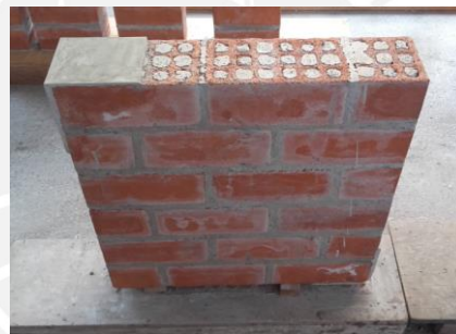
c) Murete con el capping colocado en las esquinas opuestas
