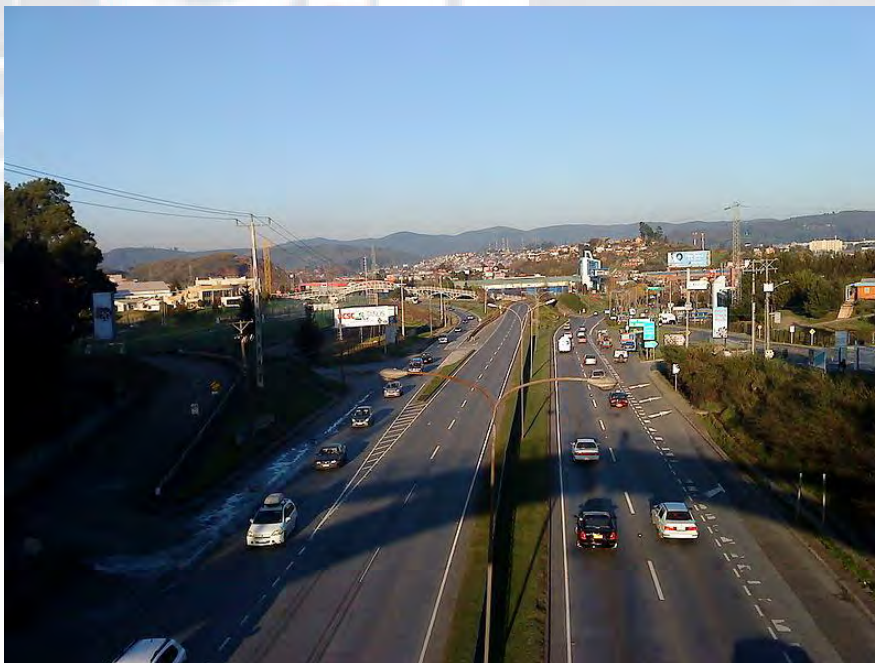
Figura 42. Enlace Paicaví - Alonso de Rivera: Autopista Concepción-Talcahuano, Chile TablaRecuperado de http://www.flickr.com/photos/annais/50389153/
