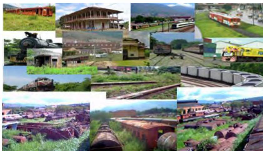
Figura 33. Estado de la estructura física y equipos del sector férreo de Colombia.
