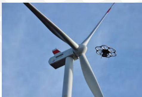
Figura 1.2 Inspección de turbinas eólicas. (Fuente: https://www.aibotix.com/en/industry.html )
