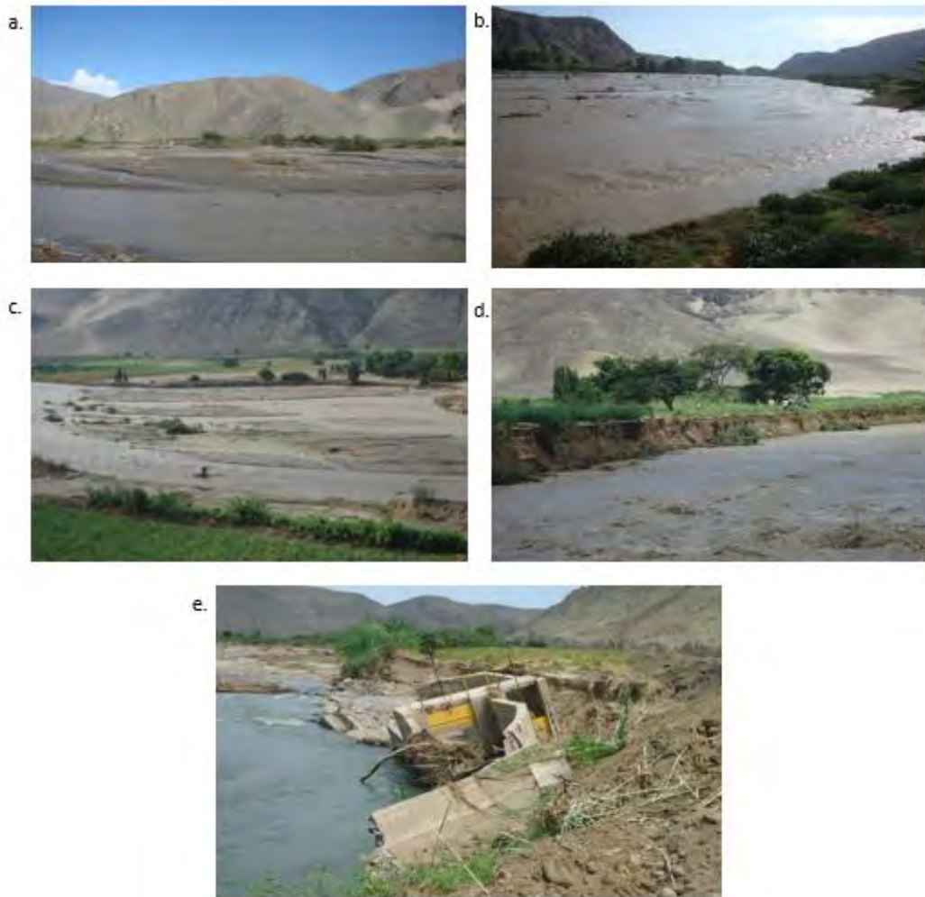
FIGURA 7: A. DESBORDE DEL RÍO Y ÁREAS DE CULTIVO PERDIDAS/AFECTADAS. ÁREAS DE CULTIVO AFECTADAS. C. CAUCE ANTIGUO DEL RIO (PARTE BAJA DE LA IMAGEN) Y ÁREAS DE CULTIVO PERDIDOS. D. ÁREAS DE CULTIVO EN PROCESO DE DESMORONAMIENTO. E. CANAL Y BOCATOMA DESTRUIDO
