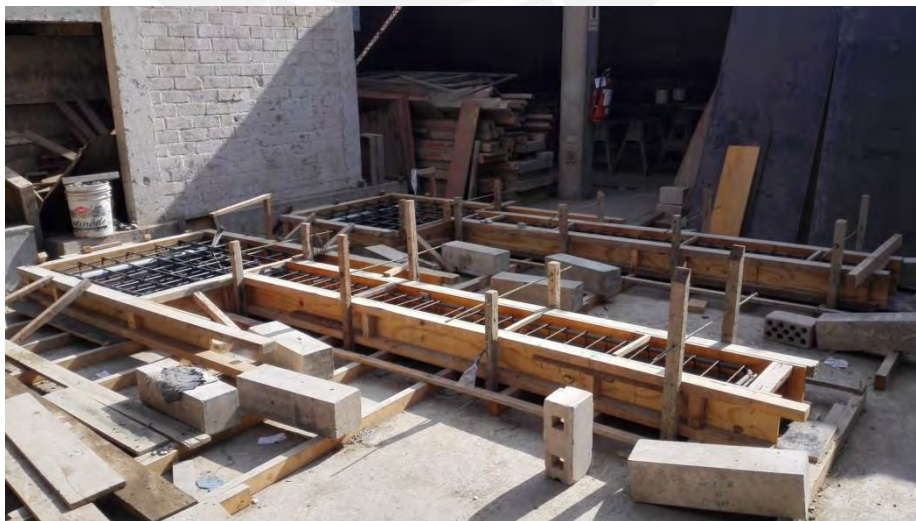
Fig.33. Encofrado concluido de las vigas
