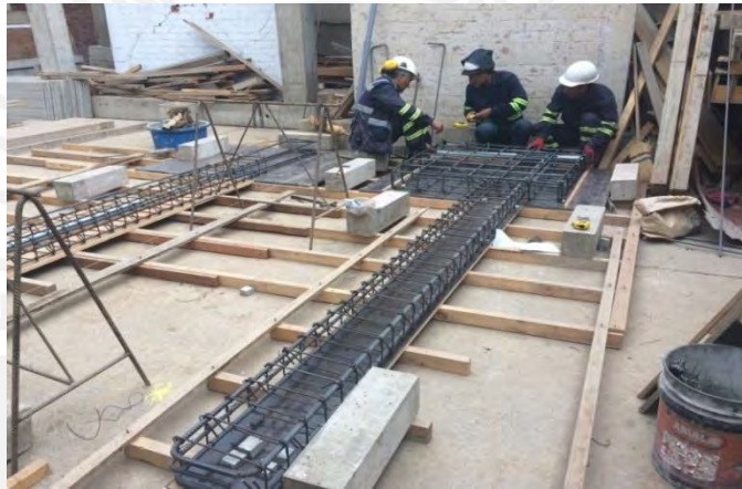
Fig.32. Armado de fierro de los especímenes
