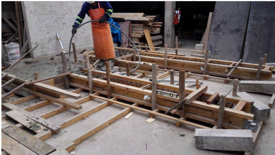
Fig. 36. Vaciado y vibrado del concreto en vigas
