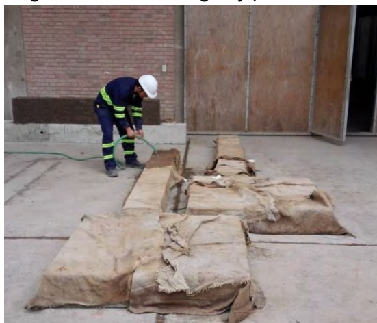
Fig. 39. Curado de vigas totalmente desencofradas
