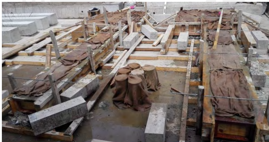
Fig. 38. Curado de vigas y probetas
