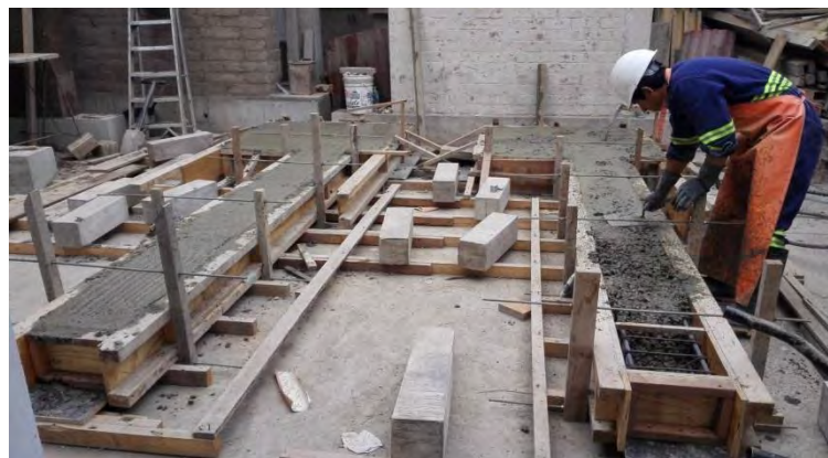
Fig. 37. Acabado en superficie libre de las vigas
